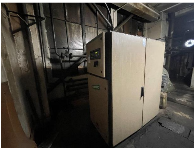
Obrázek 9 – Původní kompresor TAMROTOR [vlastní fotografie]
