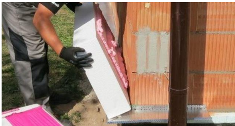
Obr 10 Lepení desek EPS 70F izolační pěnou [O4]
