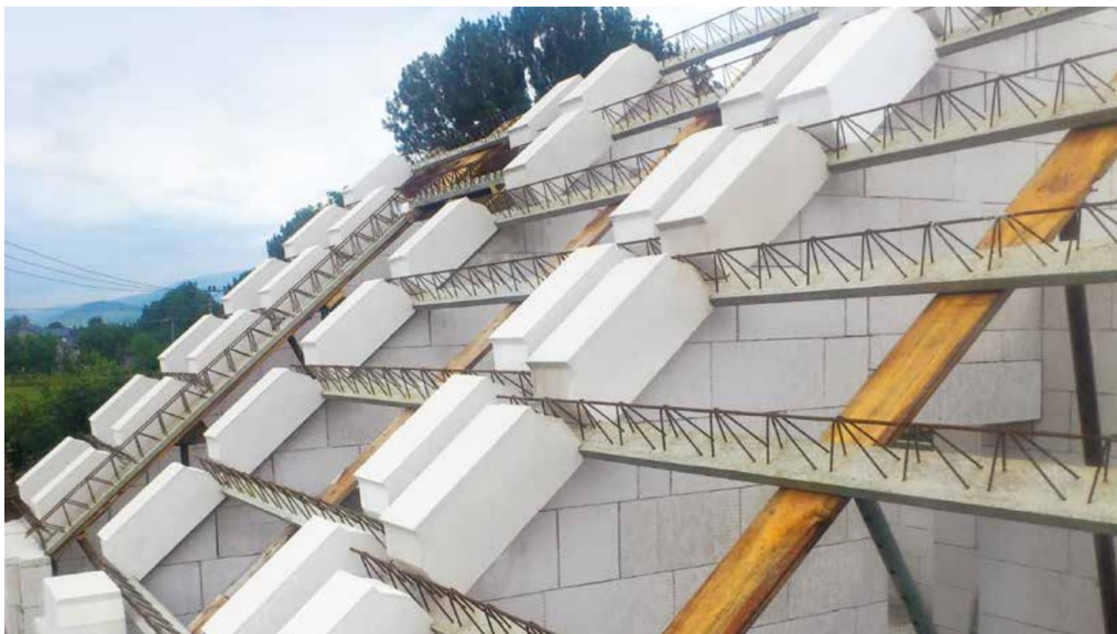
Obr. 2.1 Těžká střecha Ytong Komfort [8]
