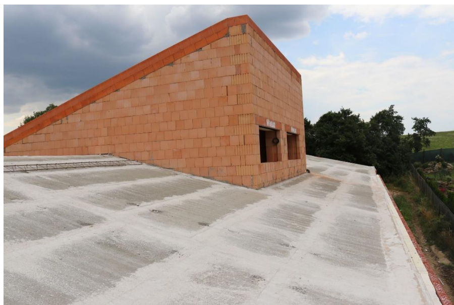
Obr. 2.33 Šikmá těžká střecha z panelů Heluz po betonáži [14]
