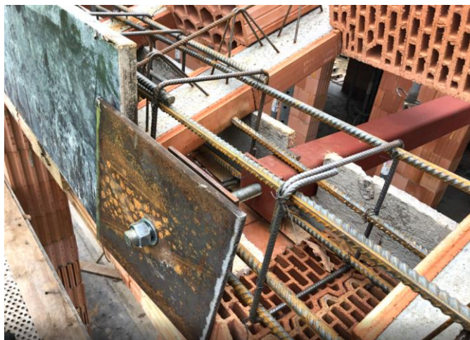
Obr. 2.26 Použití táhel pro zajištění vodorovných sil [10]
