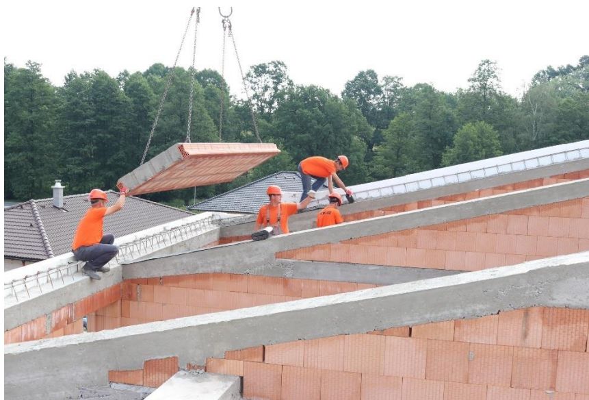
Obr. 2.31 Ukázka manipulace panelu jeřábem [14]
