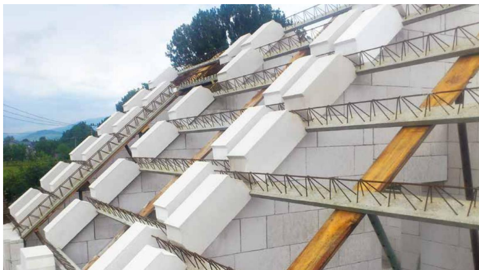
Obr. 2.8 Těžká střecha Ytong Komfort [8]
