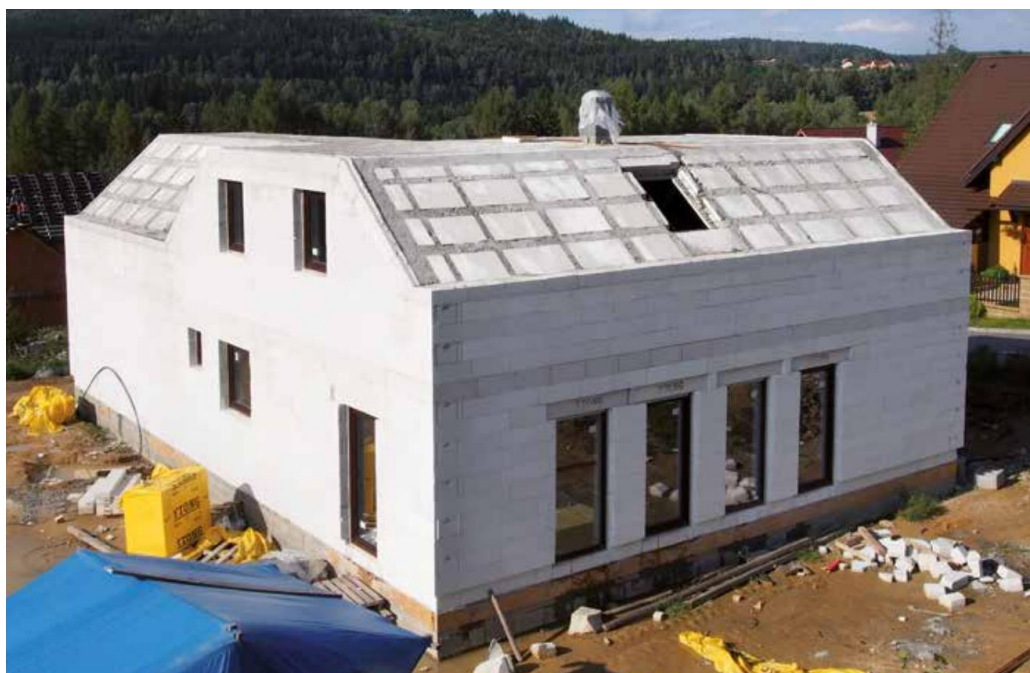
Obr. 2.14 Těžká střecha nad půdorysem tvaru L [8]
