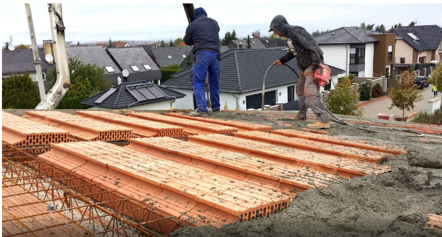
Obr. 2.24 Průběh betonáže [9]
