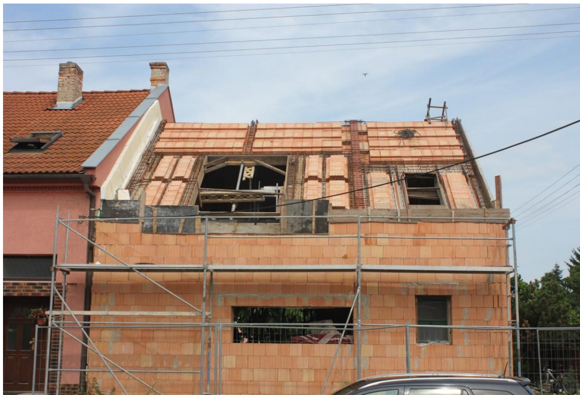
Obr. 2.16 Ukázka realizace těžké střechy Porotherm [7]
