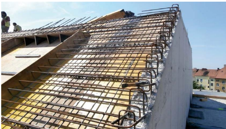
Obr. 2.34 Ukázka připraveného bednění pro sedlovou střechu ze železobetonu [18]
