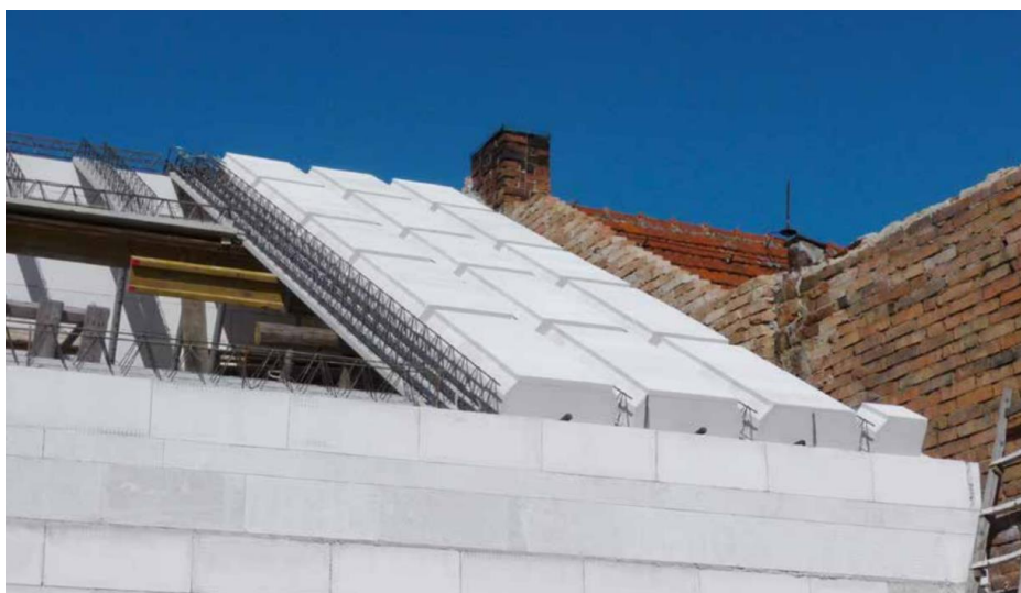
Obr. 2.4 Ukázka uložení nosníků ve spádu [8]
