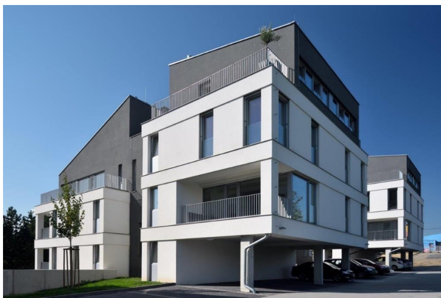
Obr. 3.2 Fotografie bytového domu [19]
