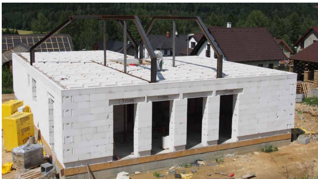
Obr. 2.13 Ukázku podpůrného ocelového rámu [8]
