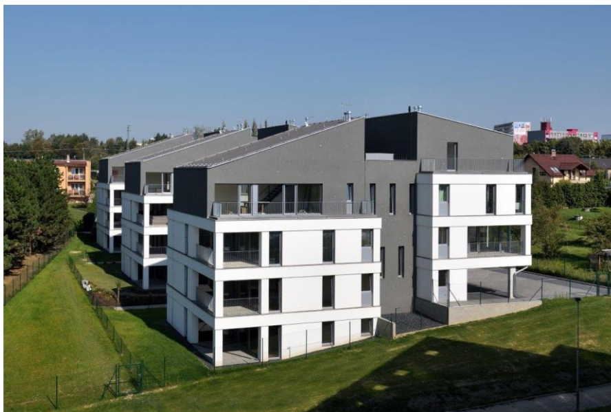
Obr. 3.1 Fotografie bytového domu [19]
