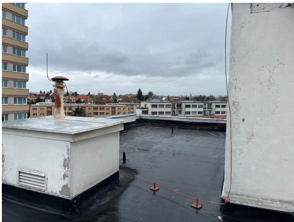
Obrázek 6-6: Pohled na severozápad ze spodní části střechy
