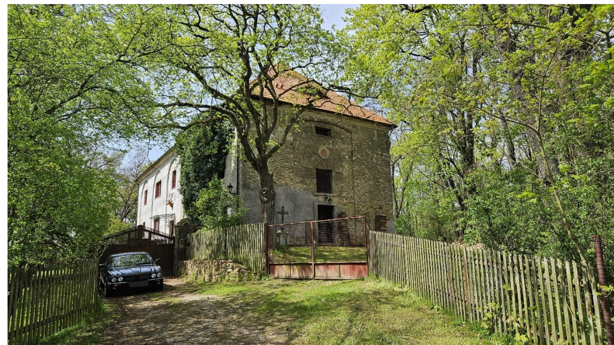
Lázovice, bývalý hospodářský objekt – sýpka (Fořtant) z počátku 19. století s klasicistním architektonickým členěním bočních fasád slepými arkádami, na silnici směr Nové Dvory
