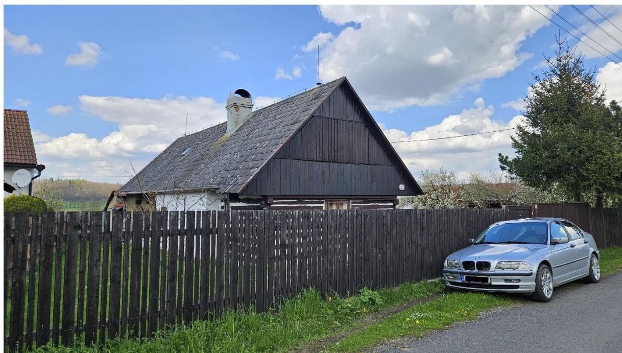
Vížina, venkovská usedlost čp. 48 ve Vížině Souřadnice stanoviště N 49.8579008, E 14.1058664 David Sochor 2023-04-21
