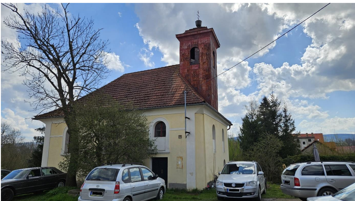
Všeradice, klasicistní stavba bývalé synagogy v historickém jádru obce, dnes husitský kostel Souřadnice stanoviště N 49.8744172, E 14.1079144 David Sochor 2023-04-21
