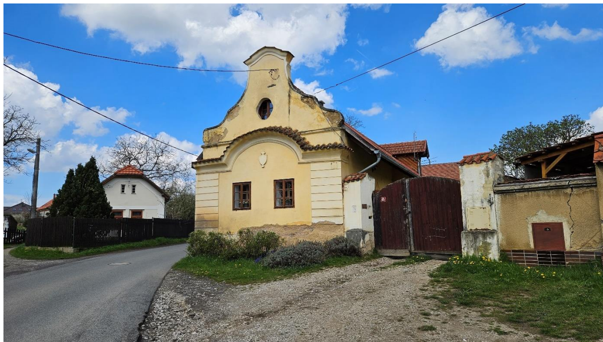
Osov, pozdně venkovská usedlost z konce 18. století na severním konci Všeradic směrem na Bykoš Souřadnice stanoviště N 49.8751122N, E 14.1011017 David Sochor 2023-04-21
