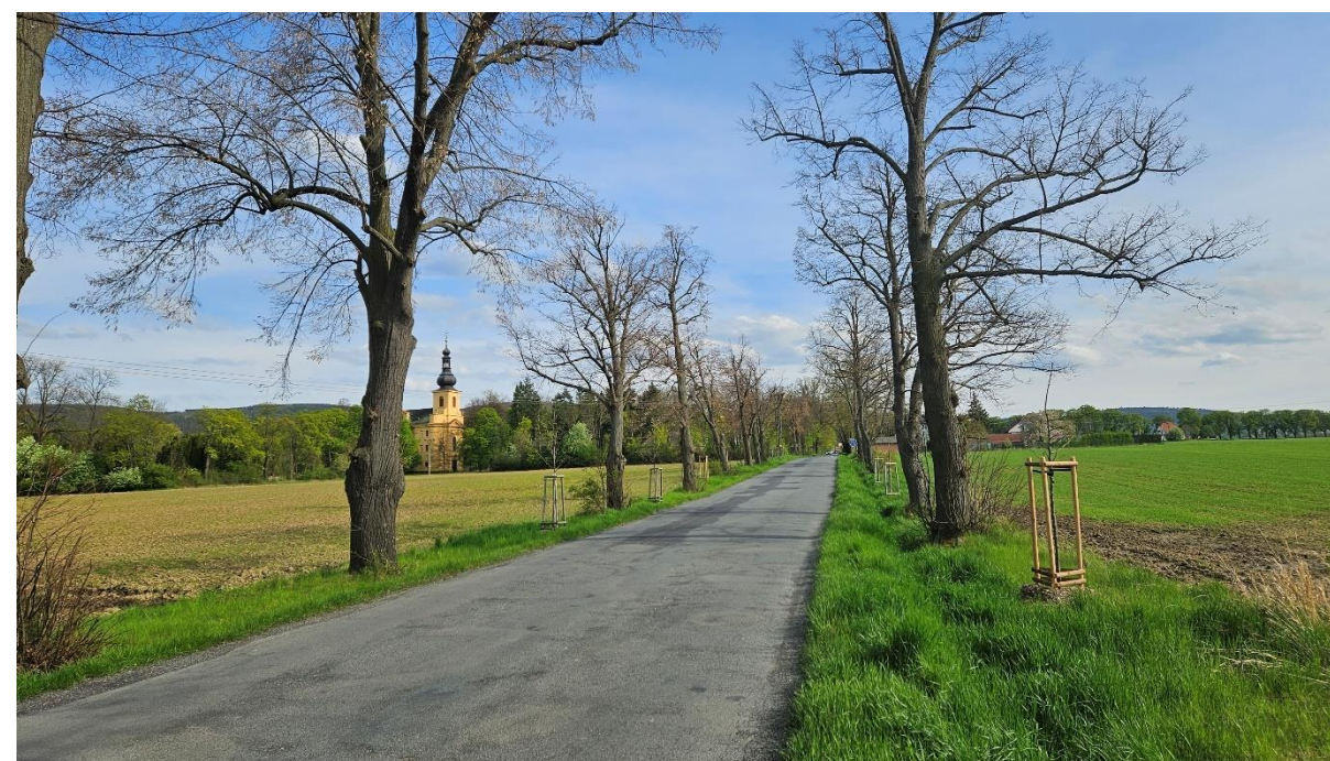
Skřípel, severní pohled na dominantní stavbu kostela sv. Jana Křtitele ze severojižní jírovcové aleje Souřadnice stanoviště N 49.8498725N, E 14.0783664 David Sochor 2023-05-01
