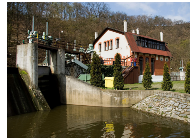
Obrázek 33 Malá vodní elektrárna Želina (zdroj: ČEZ)
