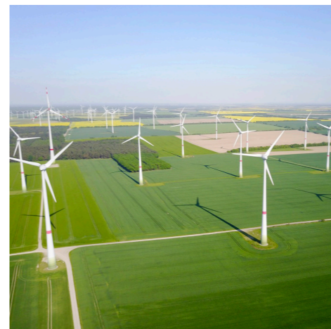
Obrázek 54 Pohled na větrný park Feldheim (zdroj: nef-feldheim.info)
