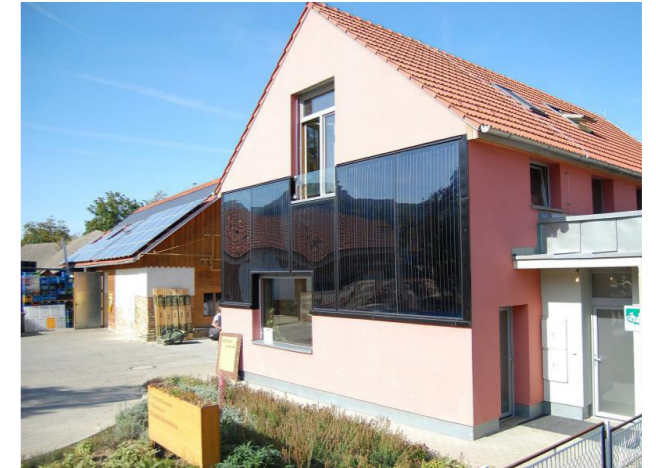
Obrázek 67 Solární kolektory na fasádě budovy v obci (zdroj: Veronica centrum Hostětín)
