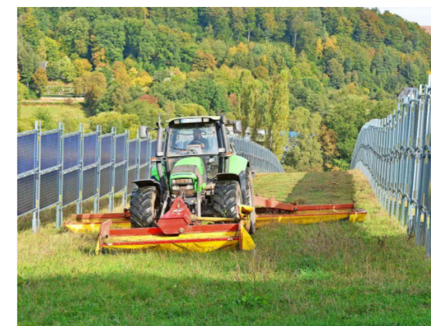
Obrázek 21 Vertikální instalace (zdroj: Next2Sun)
