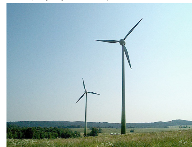
Obrázek 72 Větrná elektrárna Jindřichovice pod Smrkem (zdroj: url 33 )
