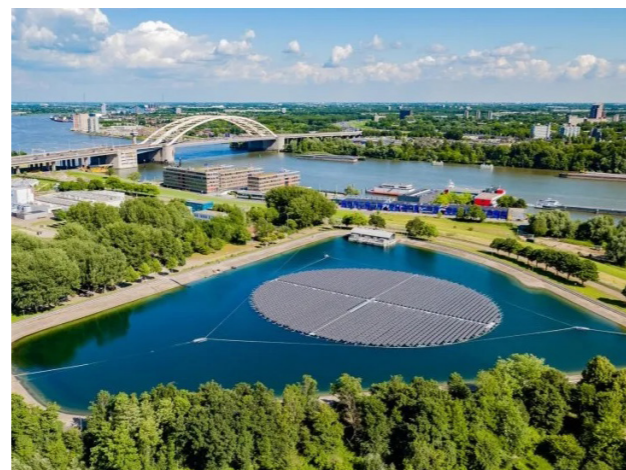
Obrázek 23 Dynamická plovoucí elektrárna Rotterdam, Nizozemsko (zdroj: witteveenbos)
