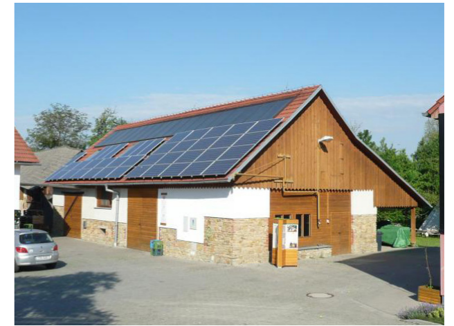
Obrázek 65 Instalace fotovoltaických panelů na střeše obecní moštárny (zdroj: Veronica centrum Hostětín)
