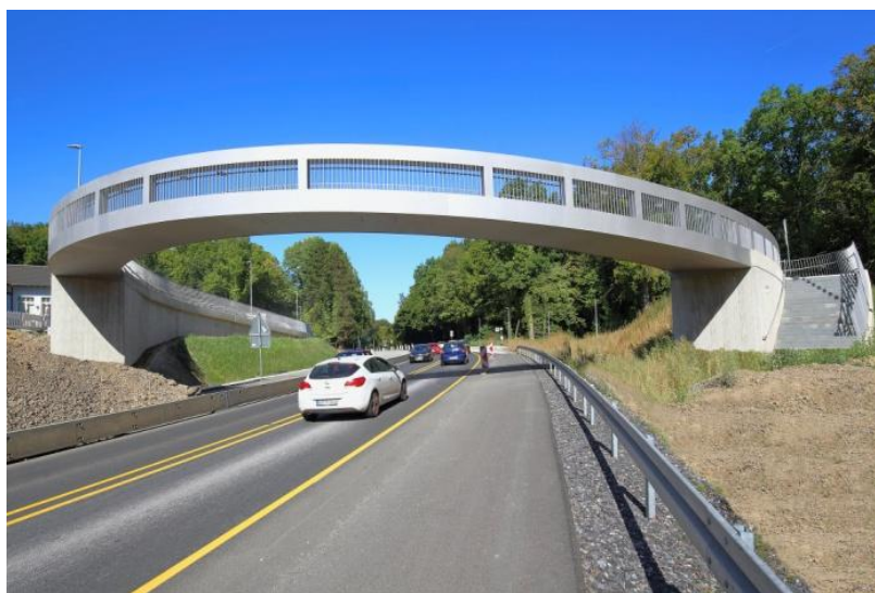
Obr. 1.9 - Realizovaný projekt pěší lávky [13]
