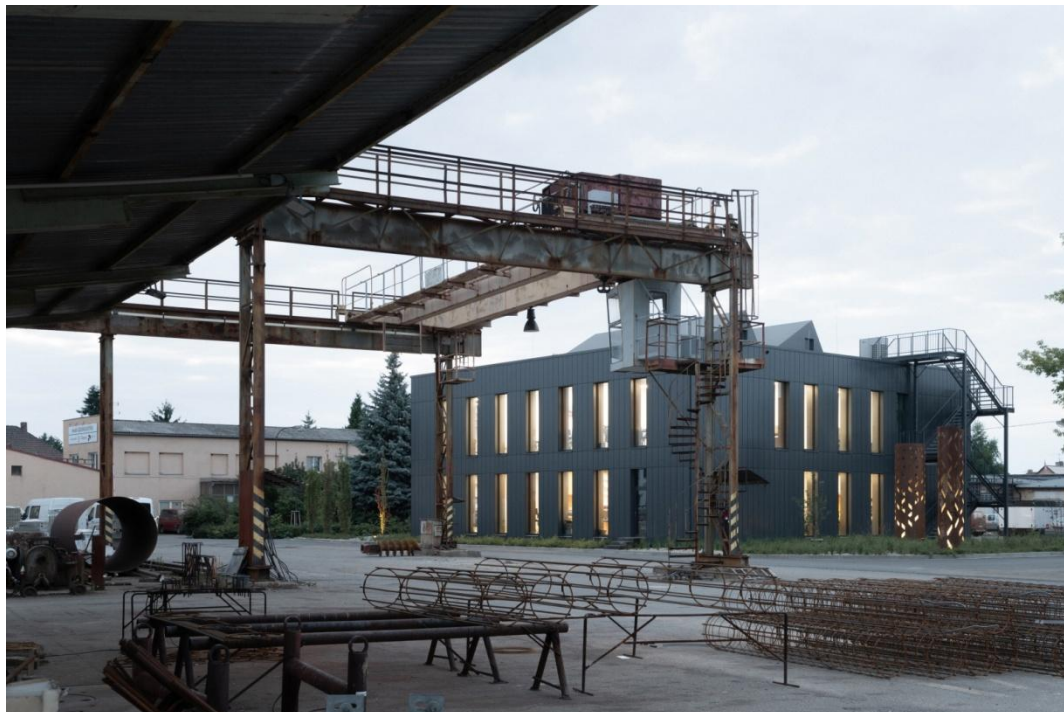
Obr. 2.1 - Řešená administrativní budova [9]
