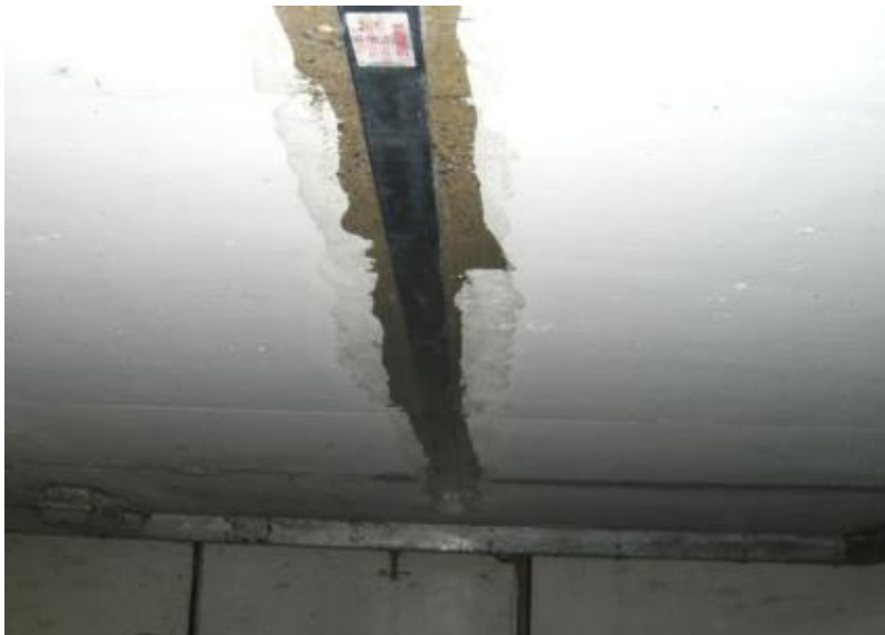
Obrázek č. 6: CFRP lamela (9)
