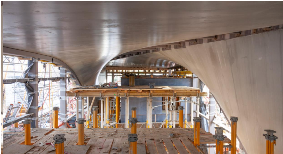
Obrázek č. 13: Pohled na výstavbu budovy CUBE (24)
