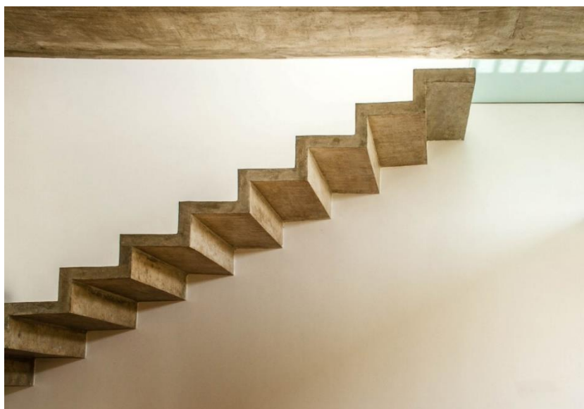
Obrázek 11: Železobetonové lomenicové schodiště [22].
