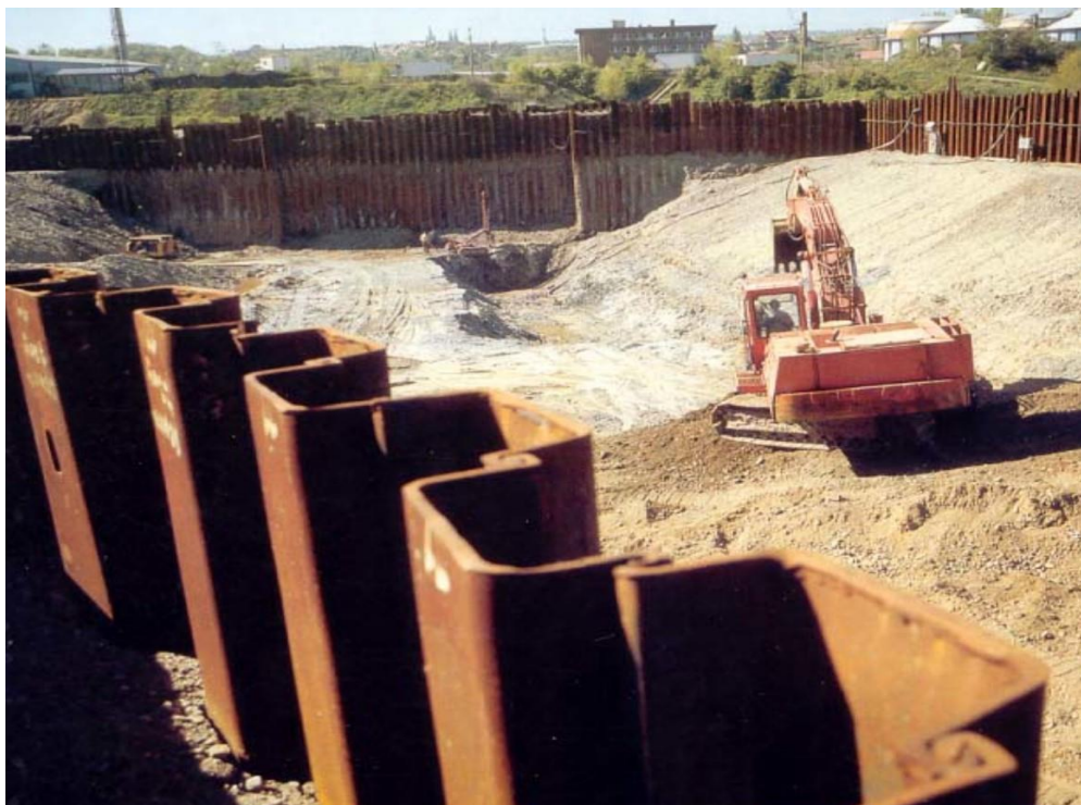
Obrázek 8: Štětová stěna typu Larsen [19].
