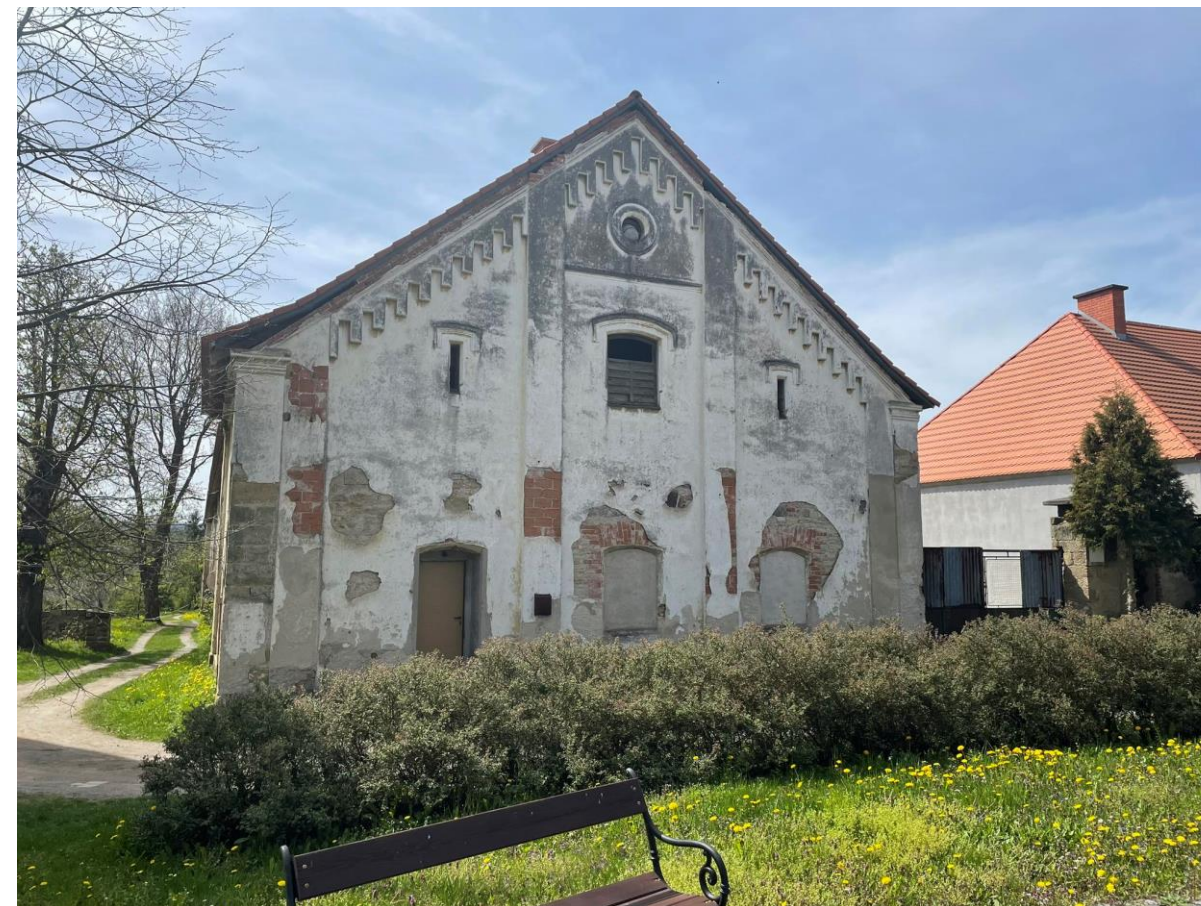
Obrázek 31: Průčelí nevyužívaného hospodářského objektu na náměstí
