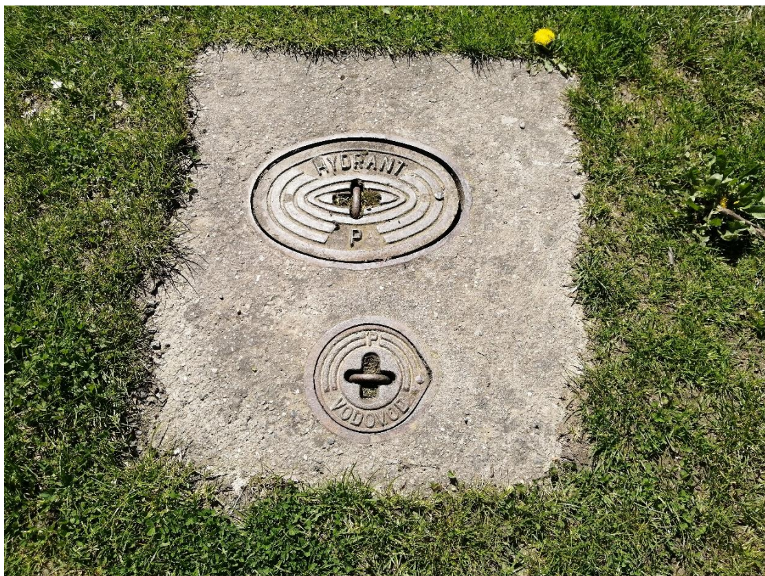
Obrázek 19: Požární hydrant u zvonice na náměstí
