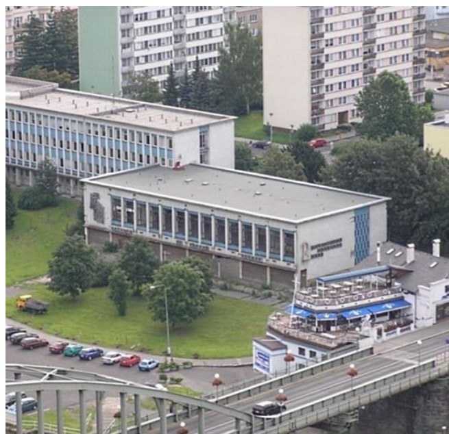
Obrázek 9: Budova Atlantik před demolicí [19]
