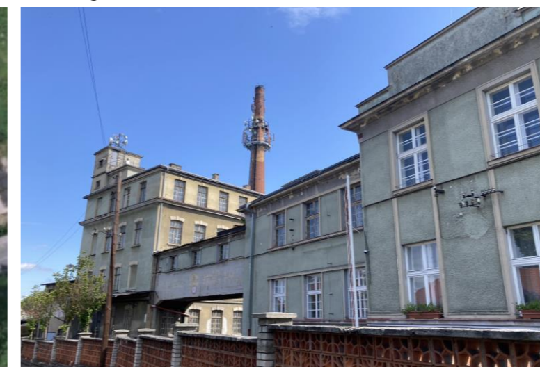
Fotografie současného stavu
