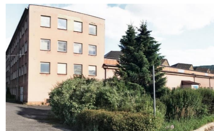
Obrázek 13: Budova firmy TOS před rekonstrukcí [21]
