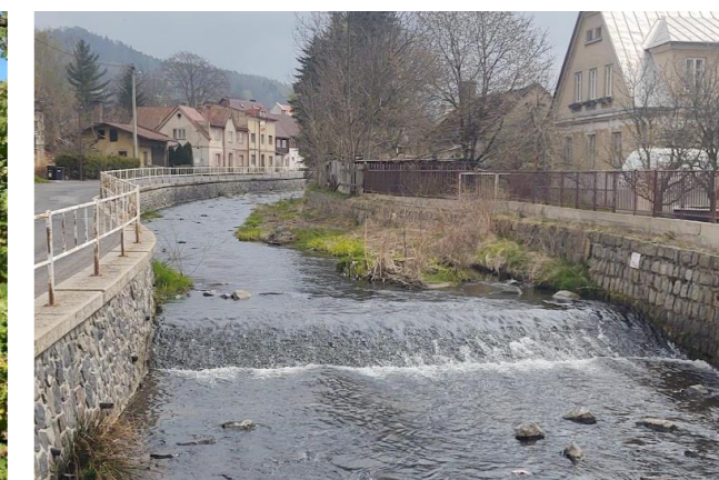
Obrázek 28: Zpevněné koryto v zastavěném území obce
