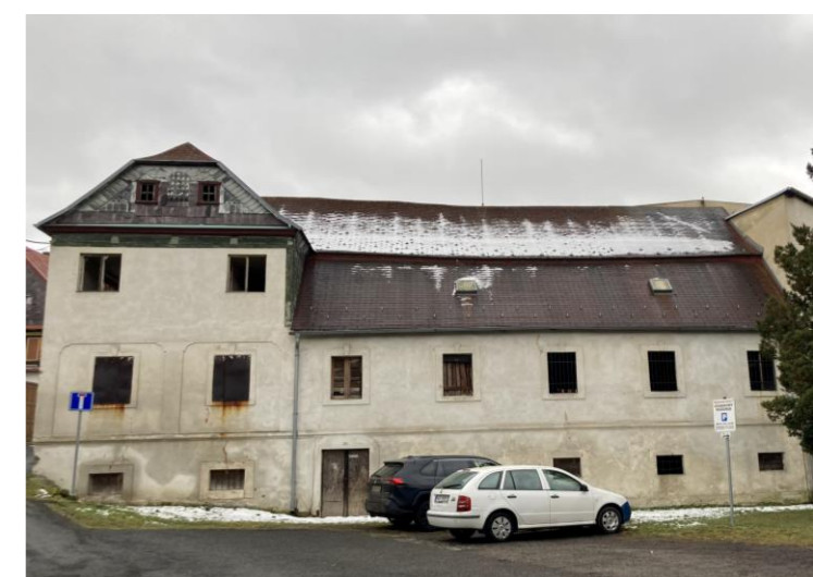
Fotografie současného stavu
