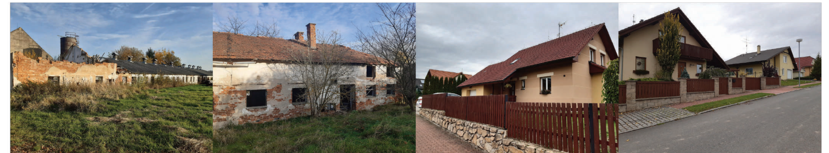
objekt určený k demolici
