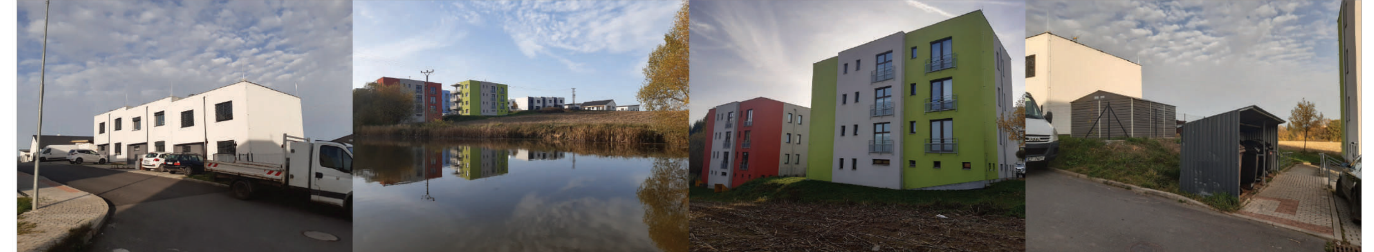
stávající zástavba řadových rodinných domů, ulice Reichnerova
