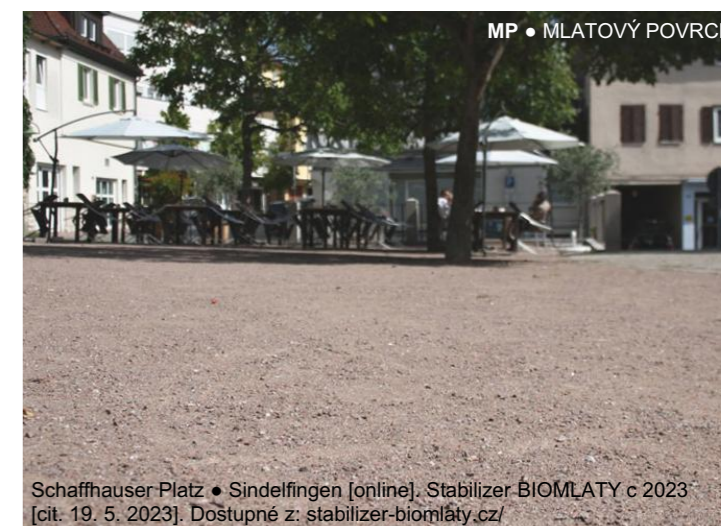
MP • MLATOVÝ POVRCH ▲ VODOPROPUSTNÝ MINERÁLNÍ MLATOVÝ POVRCH PARKDECOR® V OKROVĚM PROVEDENÍ SPLŇUJE TECHNICKOU NORMU DIN 18035-5 A LZE JEJ POUŽÍT I KOLEM KMENŮ STROMŮ • NEJEDNÁ SE O PROSÍVKU
