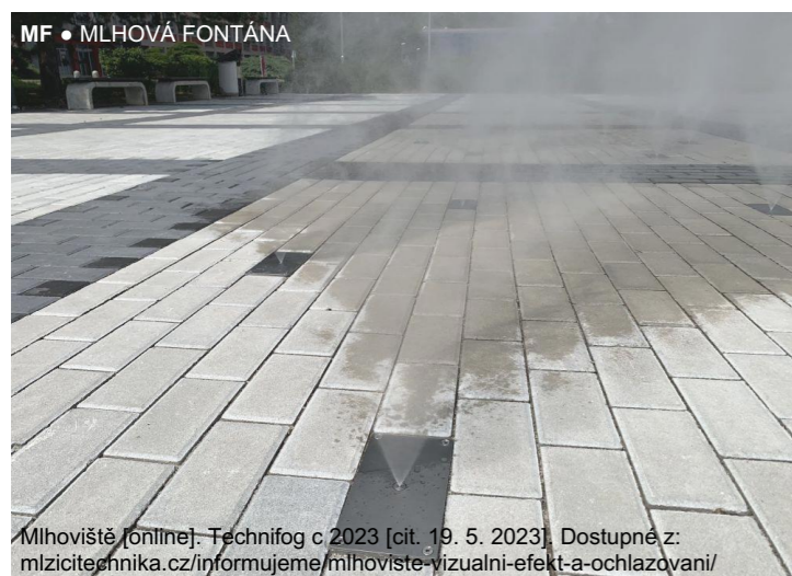
MF • MLHOVÁ FONTÁNA ▲ MLHOVÁ FONTÁNA Z 64 ROZMLŽOVACÍCH TRYSK UMÍSTĚNÝCH PO VZDÁLENOSTECH 2 x 2 m UMOŽŇUJE MLŽENÍ DO VÝŠKY 2 m • TRYSKY JSOU V NEREZOVÝCH BOXECH POD VELKOFORMÁTOVOU DLAŽBOU
