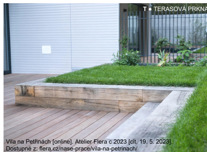
T • TERASOVÁ PRKNA ▲ HLADKÁ HOBLOVANÁ TERASOVÁ PRKNA ZE SIBIŘSKÉHO MODŘÍNU S PROFÍLEM 34 x 145 mm TVOŘÍ DŘEVĚNOU PALUBU, KTERÁ VYBÍZÍ K PŘÍJEMNÉMU POSEZENÍ POD KORUNAMI VZROSTLÝCH PLATANŮ
