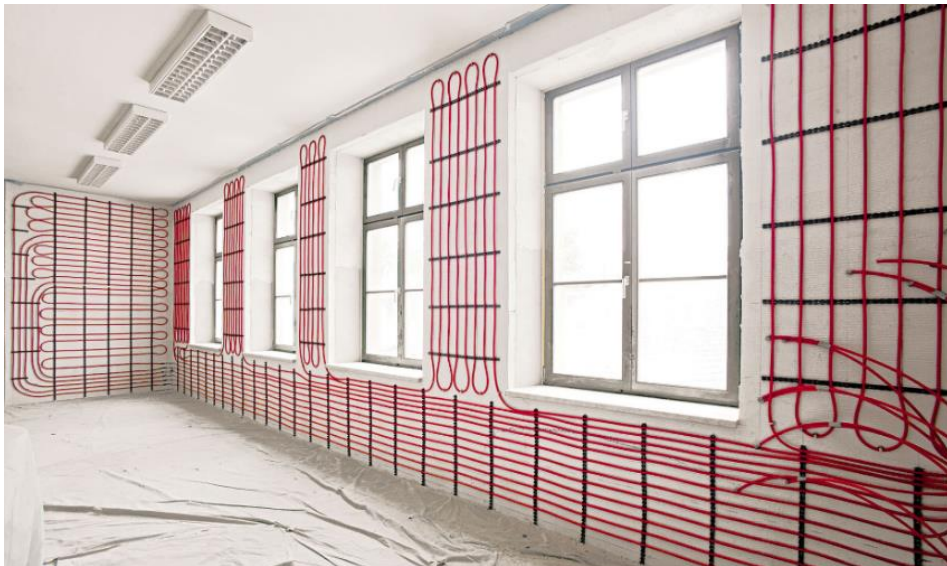
Obr. 3.7 Pokládka stěnového vytápění na obvodové stěně pro střední školu [20]
