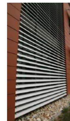
Obrázek 8: Vertikální slunolam s možností regulace
