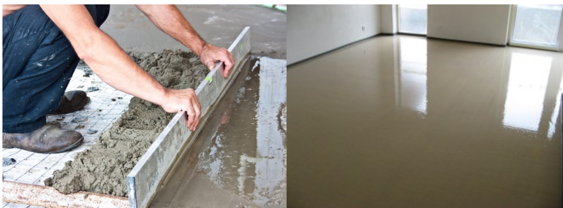
Obrázek 16: Betonová mazanina a anhydrit (53,84)
