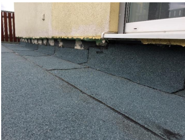
Obr.19 Hydroizolace z asfaltových pásů [41]
