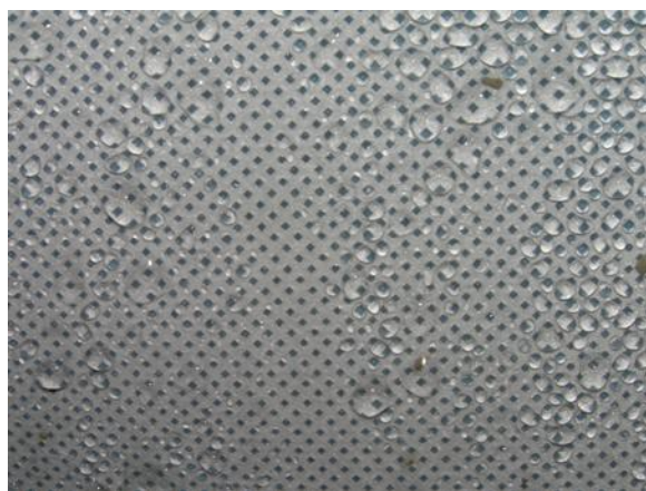
Obr.24 Zkondenzovaná voda na povrchu pojistné hydroizolace [44]
