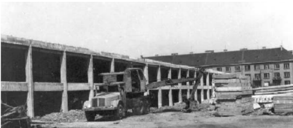
18 Historický snímek z výstavby halových laboratoří FS a FEI ČVUT zdroj: Šašková, 2014 [18]
