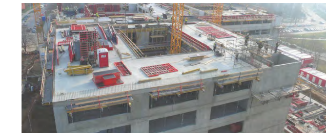
Obr.18: Výstavba budovy Fakulty architektury [11]
