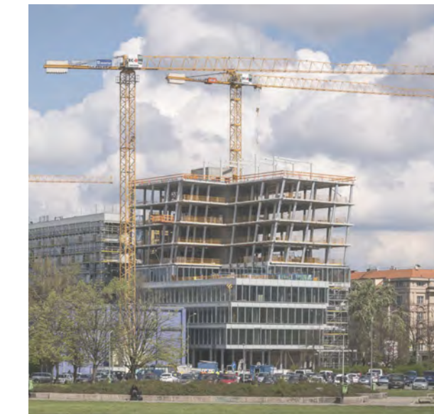
Obr.19: Výstavba budovy CIIRK [13]
