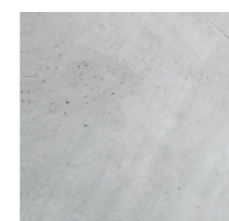
bohledový beton nosných konstrukcí
