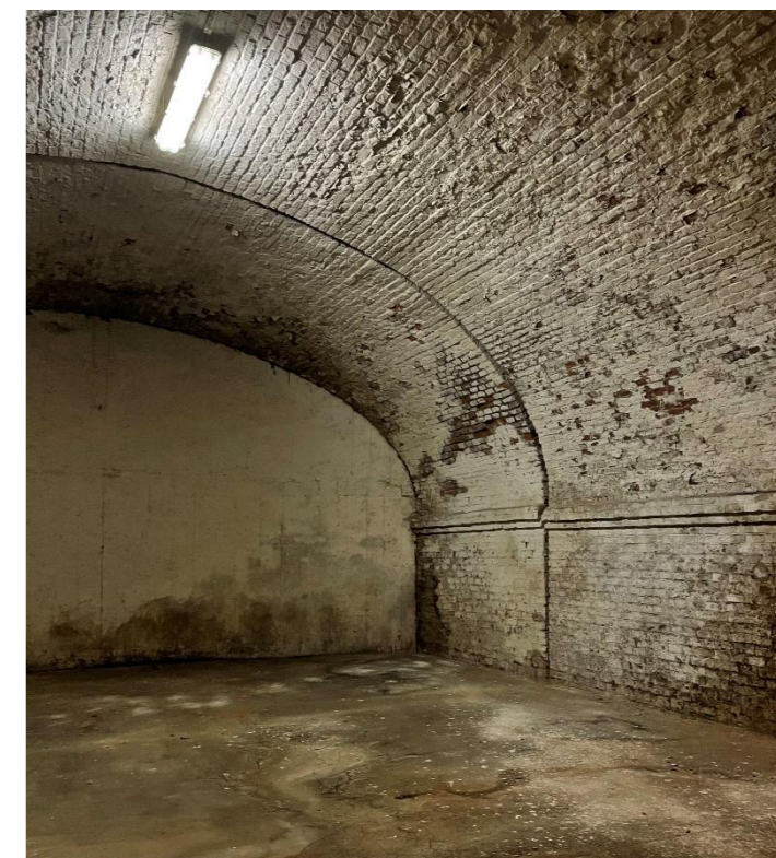
Pohled do sklepních prostor 1.NP
