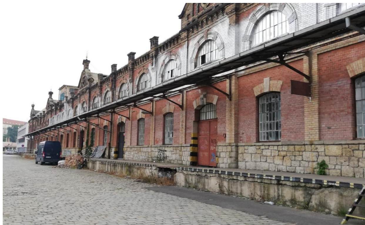
Severozápadní fasáda (2-3.NP s pochozí
