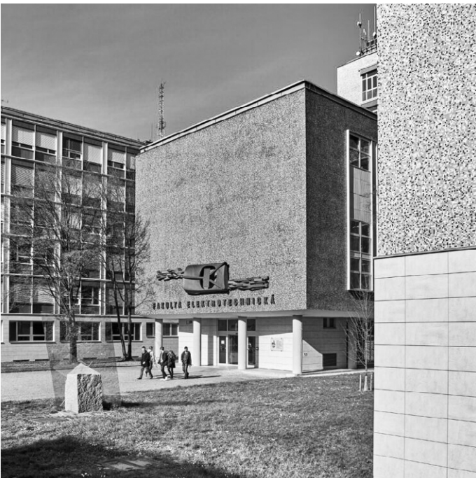
Obr. č. 4 Budova FEI ČVUT v Dejvicích
