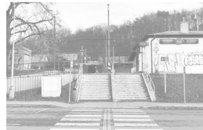
VSTUP NA VLAKOVÉ NÁDRAŽÍ stanice Posázavského Pacifiku
