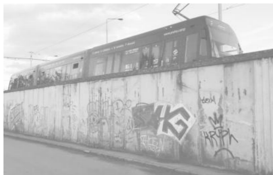
TRAMVAJ stávající stav
