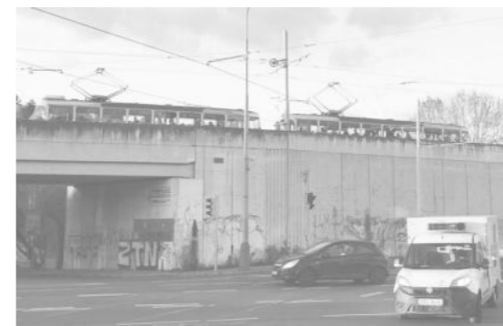
TRAMVAJ stávající umístění tramvaje na náspu
