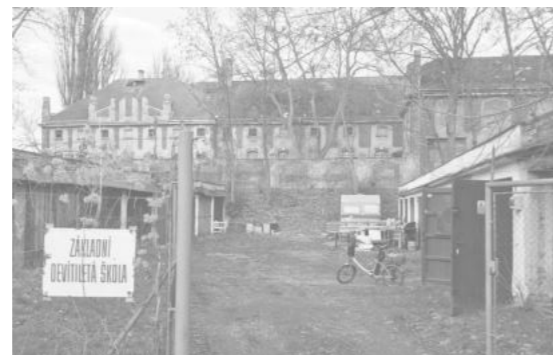
DÍLNY & GARÁŽE & SKLADY stávající stav
