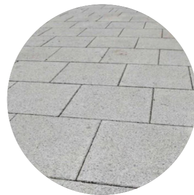
[d] Betonová dlažba
