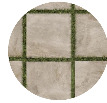
6 dlažba se zatravněnou spárou
