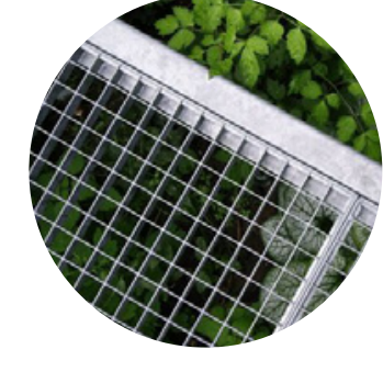
8 pororšt - nájezdová rampa do Vltavy pro kajak
