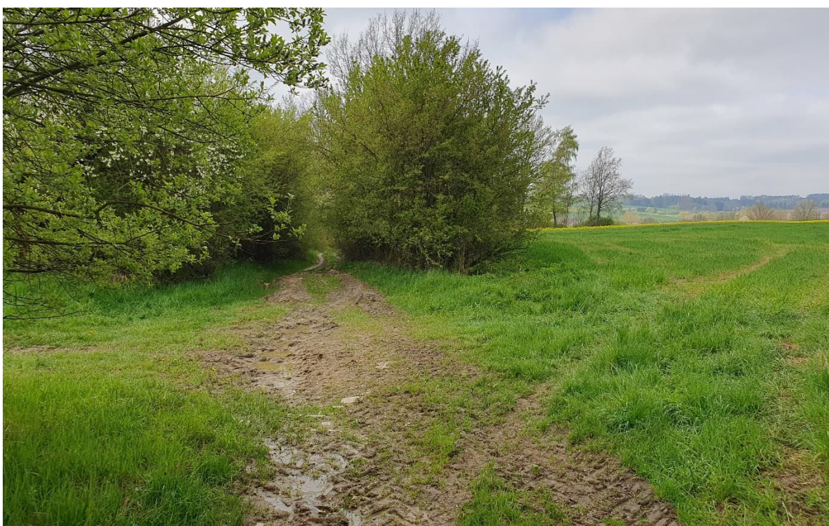
Obrázek 30 - Stav polní cesty v prostoru budoucího SO 150 (zdroj: vlastní zpracování)
