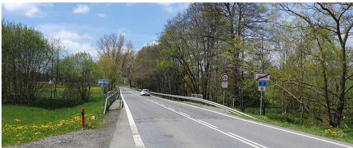
Obrázek 14 – Svislé dopravní značení u mostku 19-057 (zdroj: vlastní zpracování)
