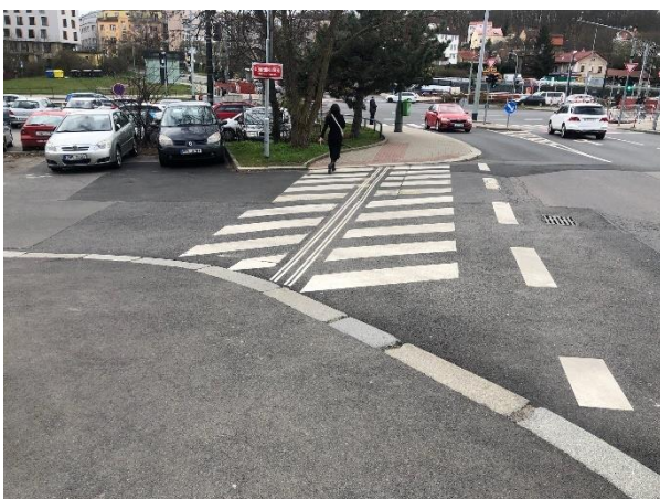
Obr. 10: Křižovatka č. 1 - Chybějící vodorovné značení pro OOSPO 24
