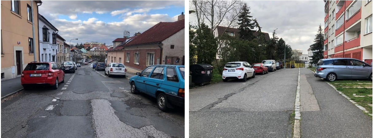
Obr. 66: Úsek č. 55 - Nedostatečný průjezdný profil 81
