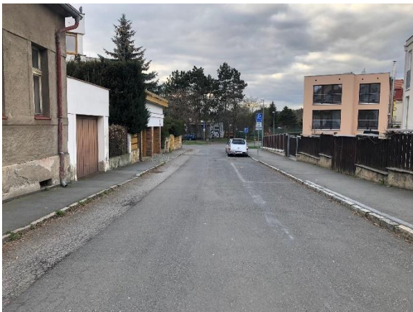
Obr. 61: Úsek č. 50 - Nedostatečný průjezdný profil 74
