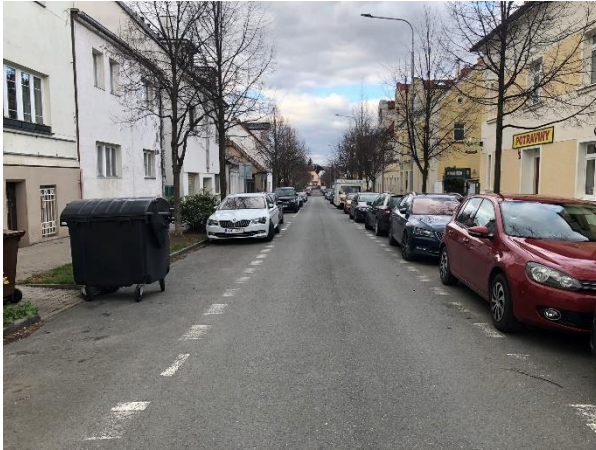
Obr. 69: Úsek č. 57 - Nedostatečný průjezdný profil 84
