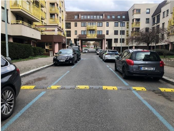
Obr. 70: Úsek č. 58 - Nedostatečný průjezdný profil 86
