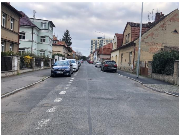
Obr. 62: Úsek č. 51 - Nedostatečný průjezdný profil 77
