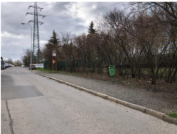
Obr. 49: Úsek č. 23 - Chybějící vodorovné dopravní značení zastávky autobusu 61
