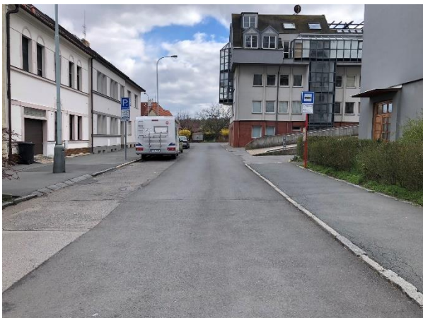
Obr. 50: Úsek č. 24 - Chybějící vodorovné dopravní značení zastávky autobusu 63
