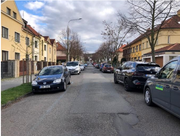
Obr. 60: Úsek č. 49 - Nedostatečný průjezdný profil 74
