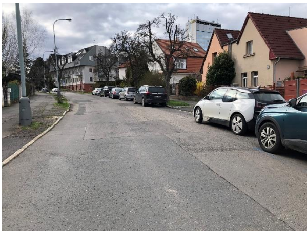
Obr. 53: Úsek č. 28 - Parkování mimo vyznačená místa 68
