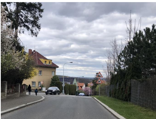
Obr. 19: Křižovatka č. 9 - Chybějící svislé dopravní značení 32
