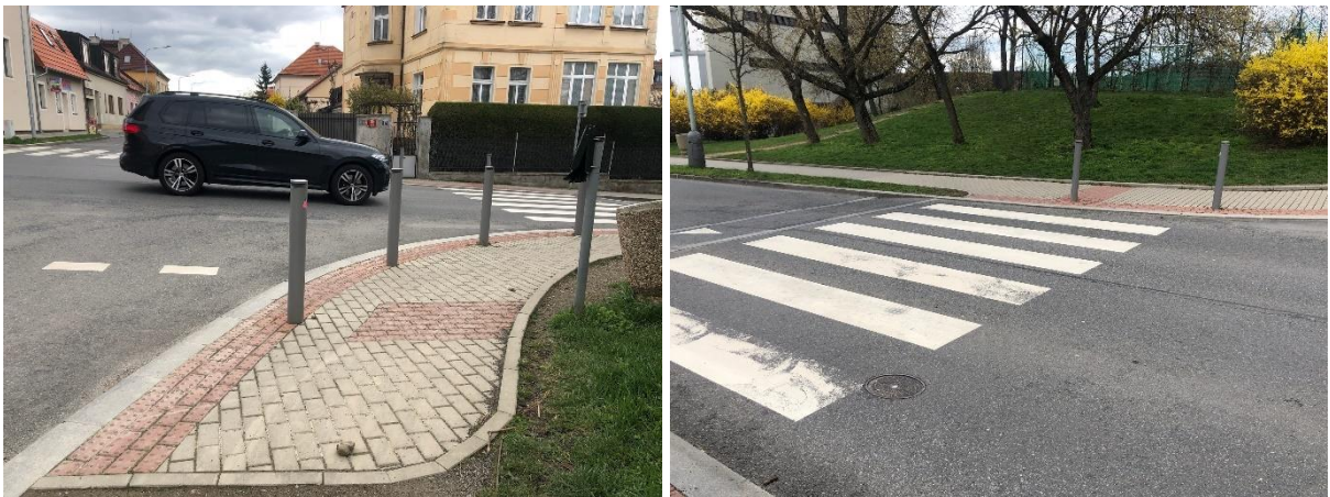
Obr. 12: Křižovatka č. 4 - Chybně provedené vodorovné značení pro OOSPO v prostoru křižovatky 25
