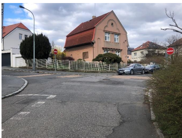
Obr. 26: Křižovatka č. 21 - Nevhodující povrch komunikace 39
