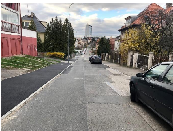
Obr. 68: Úsek č. 56 - Nedostatečný průjezdný profil 83
