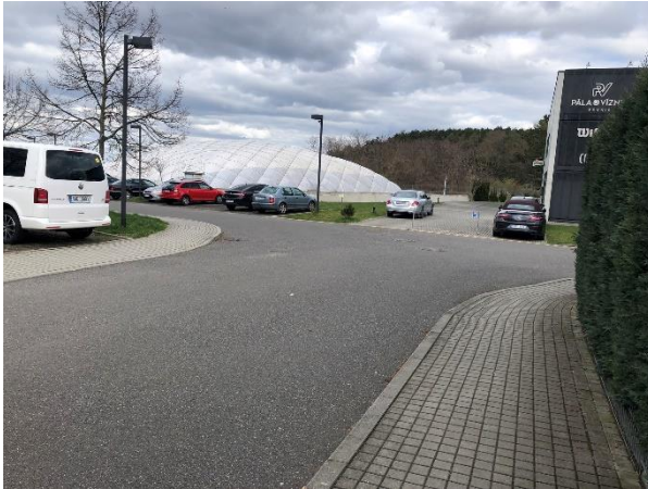
Obr. 14: Křižovatka č. 7 - Chybějící vodorovné značení pro OOSPO 28
