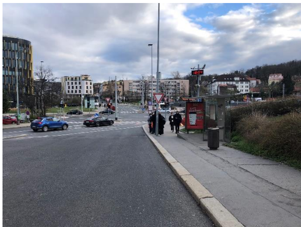
Obr. 35: Úsek č. 3 - Chybějící vodorovné dopravní značení zastávky autobusu 50
