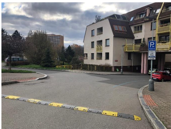
Obr. 31: Křižovatka č. 34 - Chybně provedené vodorovné značení pro OOSPO v místě pro přecházení 44
