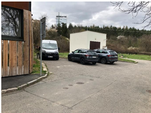
Obr. 46: Úsek č. 19 - Parkování mimo vyznačená místa 59
