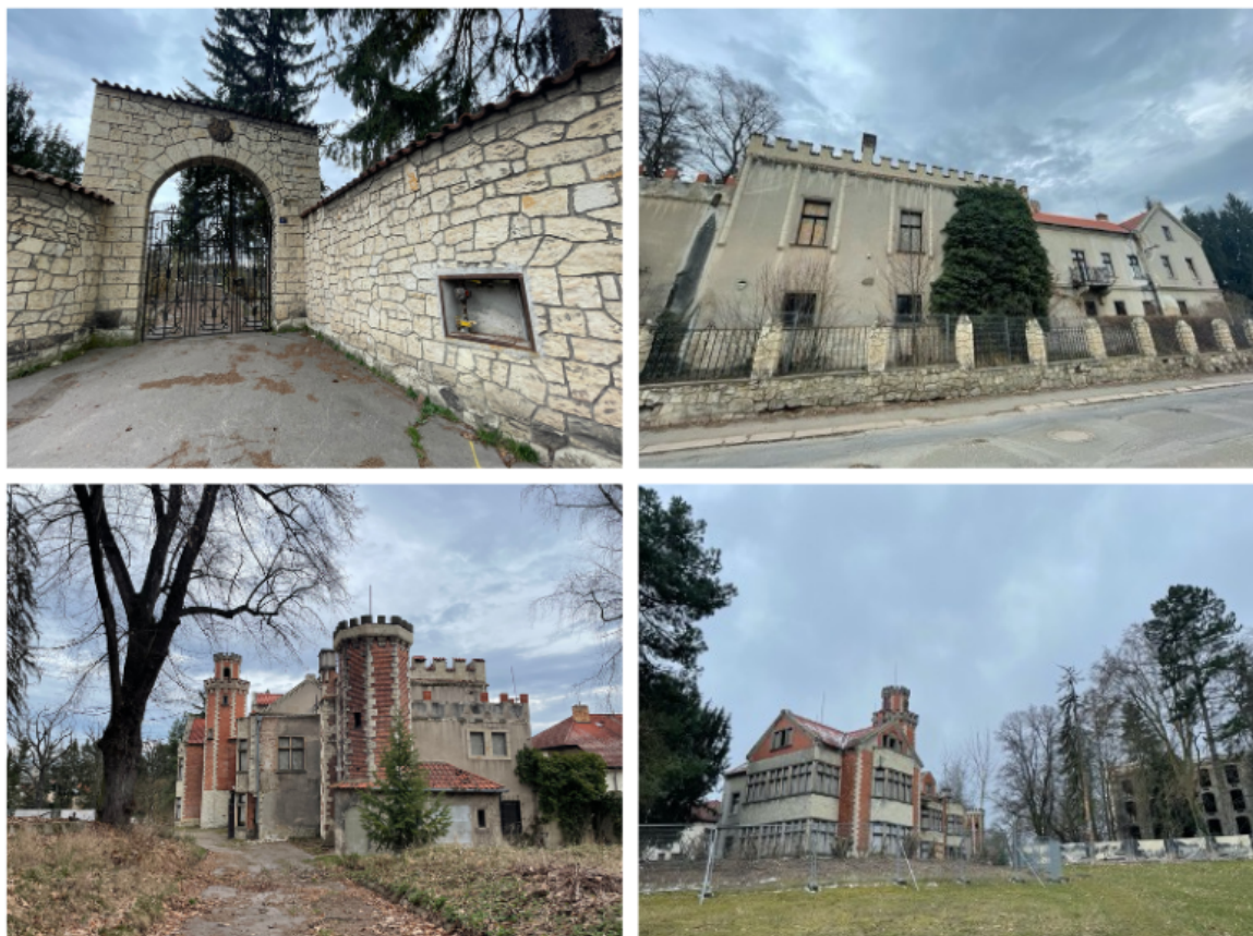
OBRÁZEK 8 SOUČASNÝ STAV VILY TOVÁRNÍKA PŘIBYLA VE SLANÉM – HORNÍ ČÁST OBRÁZKU - POHLED Z ČÁSTI PŘILEHLÉHO PARKU, SPODNÍ STRANA OBRÁZKU – POHLED Z ULICE K. H. BOROVSKEHO
