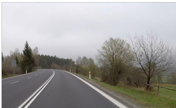
Obrázek 72 – Ilustrativní ukázka liniové vegetace v těsné blízkosti komunikace na silnici I/21 ve směru staničení km 41,073. (ID 436) [4] (PŘED ELIMINACÍ)
