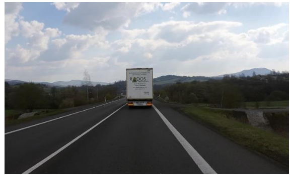
Obrázek 55 – Ilustrativní ukázka propustku pod hospodářským sjezdem na silnici I/13 ve směru staničení km 12,420. (ID 566) [4] (PO ELIMINACI)
