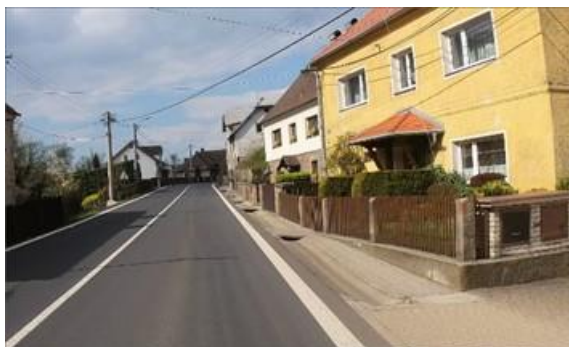
Obrázek 38 – Ukázka absence pěší infrastruktury na silnici I/13 ve směru proti staničení km 20,588. (ID 4160) [4]
