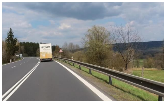
Obrázek 73 – Ilustrativní ukázka liniové vegetace v těsné blízkosti komunikace na silnici I/21 ve směru staničení km 41,073. (ID 436) [4] (PO ELIMINACI)
