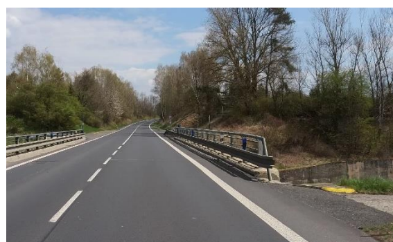
Obrázek 25 – Ukázka krátkého svodidla před mostním objektem na silnici I/21 ve směru proti staničení km 48,538. (ID 1872) [4]
