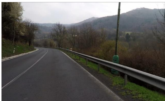
Obrázek 58 – Ilustrativní ukázka nedodržení minimální vzdálenosti za svodidlem na silnici I/13 ve směru staničení km 19,668. (ID 3370) [4] (PŘED ELIMINACÍ)
