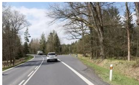
Obrázek 31 – Ukázka neadekvátně vyznačeného parkoviště na silnici I/64 ve směru staničení km 9,915. (ID 258) [4]
