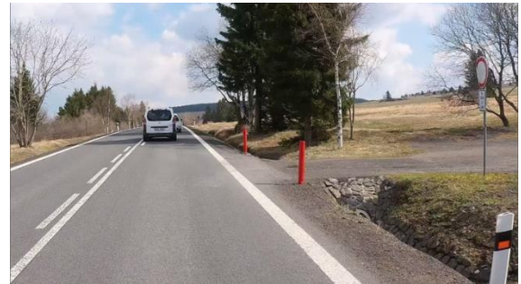
Obrázek 85 – Ilustrativní ukázka propustku pod hospodářským sjezdem na silnici I/25 ve směru staničení km 11,797. (ID 1287) [4] (PO ELIMINACI)
