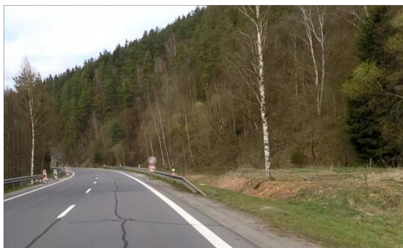
Obrázek 60 – Ilustrativní ukázka stromu v těsné blízkosti komunikace na silnici I/20 ve směru proti staničení km 12,810. (ID 1401) [4] (PŘED ELIMINACÍ)
