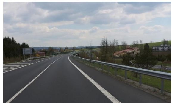
Obrázek 21 – Eliminace krátkého svodidla před mostem na silnici I/21 ve směru proti staničení km 28,954. (ID 2318) [4]
