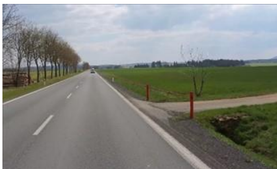
Obrázek 30 – Ukázka neadekvátního dopravního zařízení v místě samostatného sjezdu na silnici I/20 ve směru staničení km 27,677. (ID 2943) [4]
