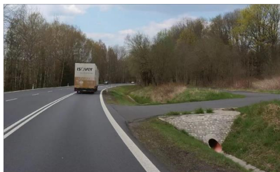
Obrázek 75 – Ilustrativní ukázka propustku pod hospodářským sjezdem na silnici I/21 ve směru staničení km 42,006. (ID 444) [4] (PO ELIMINACI)
