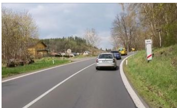
Obrázek 32 – Ukázka absence oboustranného umístění SDZ na silnici I/20 ve směru proti staničení km 3,874. (ID 3089) [4]
