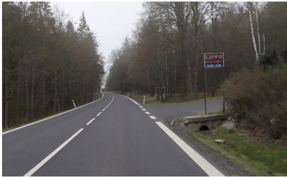
Obrázek 92 – Ilustrativní ukázka propustku pod sjezdem na silnici I/64 ve směru staničení km 8,248. (ID 240) [4] (PŘED ELIMINACÍ)
