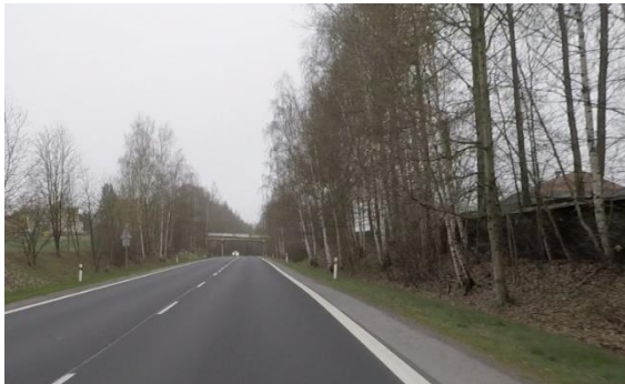
Obrázek 8 – Stromořadí představující pevnou překážku na silnici I/64 ve směru staničení km 5,015. (ID 3120) [4]
