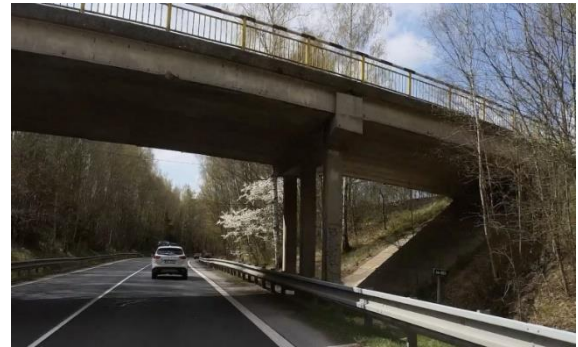
Obrázek 19 – Eliminace nedodržení minimální vzdálenosti za svodidlem na silnici I/64 ve směru staničení km 5,187. (ID 209) [4]
