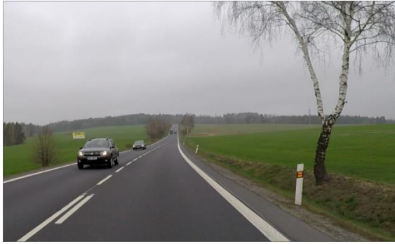
Obrázek 6 – Strom představující pevnou překážku na silnici I/21 ve směru staničení km 39,475. (ID 422) [4]
