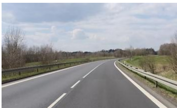
Obrázek 28 – Ukázka absence SDZ a VDZ v místě počátku zákazu předjíždění na komunikaci I/64 ve směru staničení km 12,789. (ID 281) [4]
