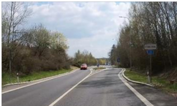
Obrázek 46 – Ukázka nevhodného umístění SDZ označující počátek intravilánového území v místě bez zastavby na silnici I/21 ve směru proti staničení km 35,064. (ID 3411) [4]
