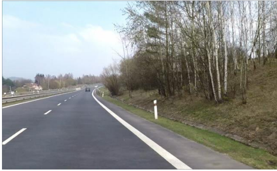
Obrázek 52 – Ilustrativní ukázka liniové vegetace v těsné blízkosti komunikace na silnici I/13 ve směru staničení km 2,105. (ID 495) [4] (PŘED ELIMINACÍ)
