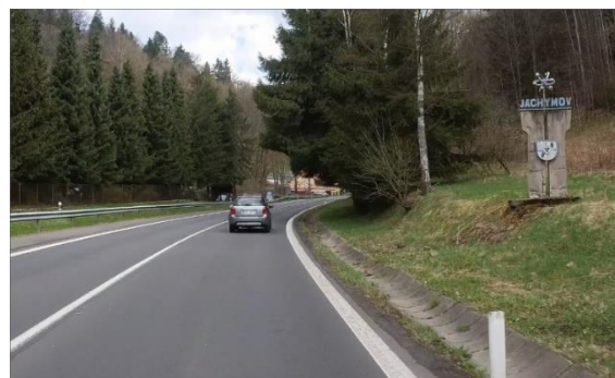
Obrázek 81 – Ilustrativní ukázka vzrostlé zeleně v těsné blízkosti komunikace na silnici I/25 ve směru staničení km 4,146. (ID 980) [4] (PO ELIMINACI)
