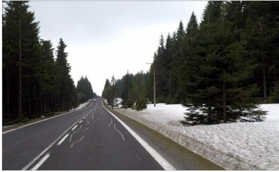
Obrázek 82 – Ilustrativní ukázka liniové vegetace v těsné blízkosti komunikace na silnici I/25 ve směru proti staničení km 11,401. (ID 1551) [4] (PŘED ELIMINACÍ)
