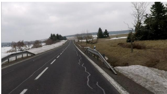
Obrázek 86 – Ilustrativní ukázka krátkého výškového náběhu na silnici I/25 ve směru staničení km 12,057. (ID 1297) [4] (PŘED ELIMINACÍ)
