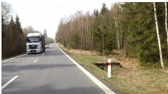
Obrázek 64 – Ilustrativní ukázka propustku pod hospodářským sjezdem na silnici I/20 ve směru proti staničení km 39,207. (ID 1075) [4] (PŘED ELIMINACÍ)
