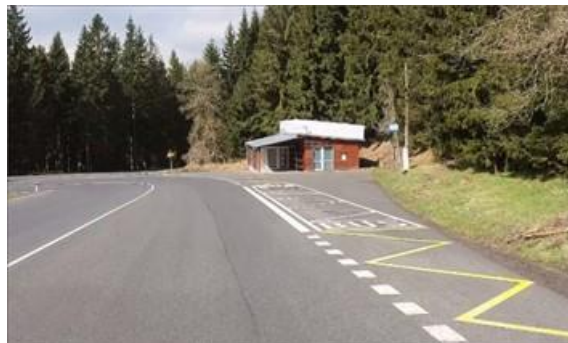
Obrázek 35 – Ukázka absence nástupní hrany a návaznosti na pěší infrastrukturu na silnici I/25 ve směru proti staničení km 9,863. (ID 1612) [4]
