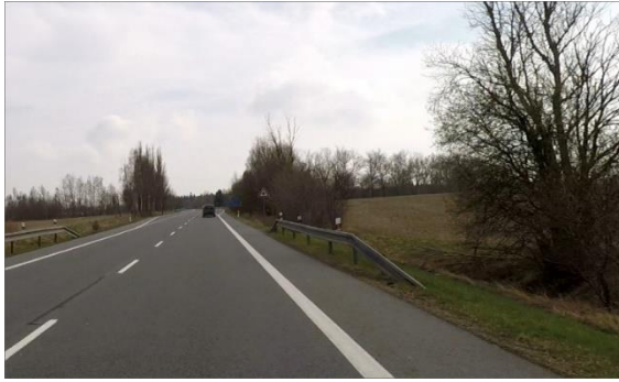
Obrázek 16 – Krátké výškové náběhy svodidla na silnici I/20 ve směru staničení km 32,012. (ID 941) [4]
