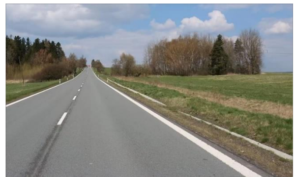
Obrázek 11 – Zrušení sjezdu vedoucí k odstranění tuhého čela propustku na silnici I/20 ve směru proti staničení km 37,821. (ID 1132) [4]
