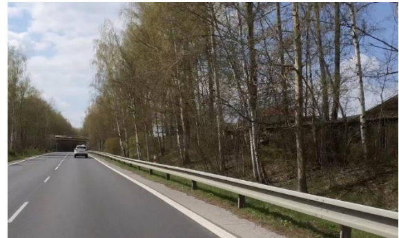
Obrázek 9 – Eliminace stromu ochranou svodidly na silnici I/64 ve směru staničení km 5,015. (ID 3120) [4]
