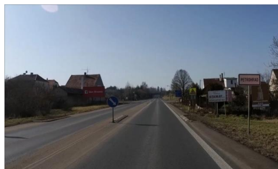
Obrázek 45 – Ukázka neadekvátní změny charakteru komunikace na silnici I/6 z databáze silniční sítě TEN-T ve směru staničení km 66,075. (ID 5217) [4]
