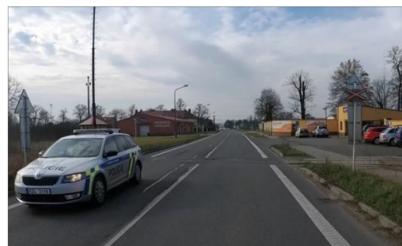
Obrázek 33 – Ukázka neadekvátně postřehnutelného železničního přejezdu na silnici I/55 z databáze silniční sítě TEN-T ve směru staničení km 83,971. (ID 10432) [4]
