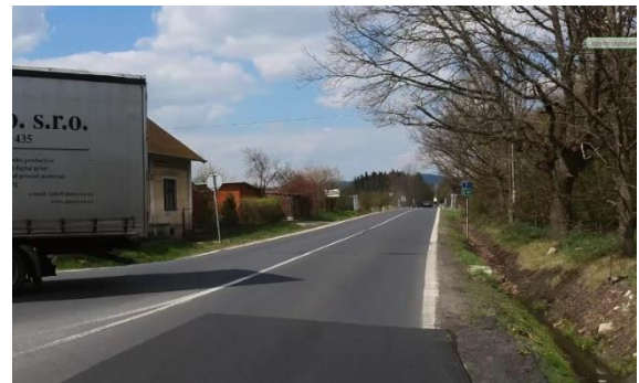
Obrázek 15 – Úprava příkopu na silnici I/21 ve směru staničení km 56,102. (ID 2360) [4]
