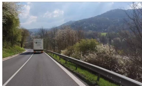
Obrázek 59 – Ilustrativní ukázka nedodržení minimální vzdálenosti za svodidlem na silnici I/13 ve směru staničení km 19,668. (ID 3370) [4] (PO ELIMINACI)
