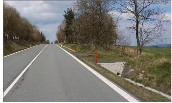
Obrázek 13 – Zešikmené tuhé čelo propustky pod sjezdem na silnici I/20 ve směru proti staničení km 37,402. (ID 1147) [4]
