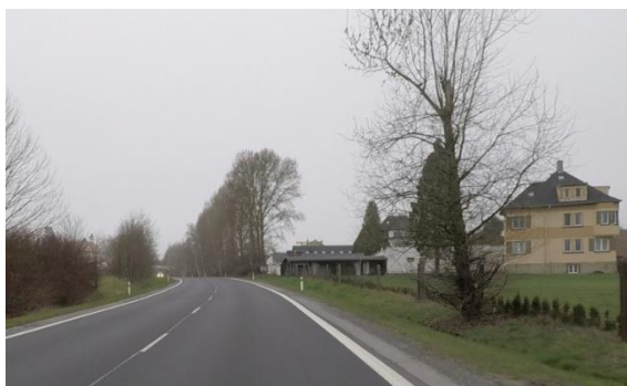
Obrázek 88 – Ilustrativní ukázka stromu v těsné blízkosti komunikace na silnici I/64 ve směru staničení km 4,887. (ID 204) [4] (PŘED ELIMINACÍ)
