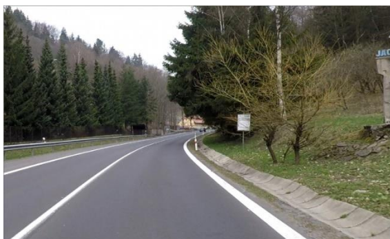
Obrázek 80 – Ilustrativní ukázka vzrostlé zeleně v těsné blízkosti komunikace na silnici I/25 ve směru staničení km 4,146. (ID 980) [4] (PŘED ELIMINACÍ)
