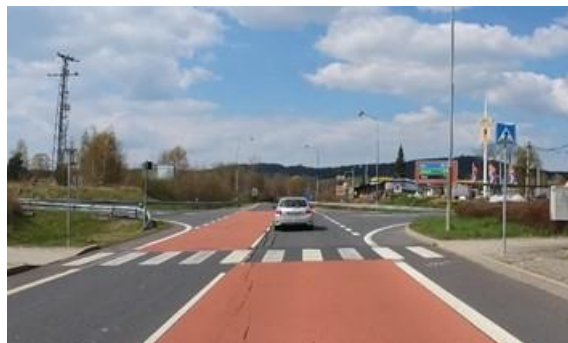
Obrázek 37 – Ukázka dlouhého neděleného přechodu pro chodce na silnici I/21 ve směru staničení km 60,077. (ID 2418) [4]
