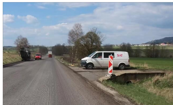
Obrázek 23 – Ukázka tuhého čela v místě hospodářského sjezdu na silnici I/21 ve směru staničení km 32,262. (ID 345) [4]
