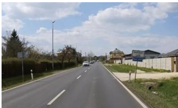
Obrázek 44 – Ukázka absence zklidňujícího opatření na silnici I/64 ve směru staničení km 0,354. (ID 141) [4]
