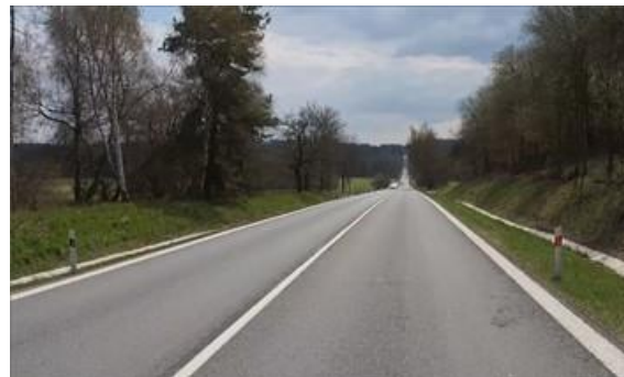
Obrázek 47 – Ukázka nevhodného umístění VDZ zakazující předjíždění na silnici I/20 ve směru staničení km 37,342. (ID 1000) [4]
