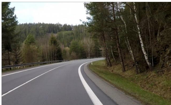
Obrázek 62 – Ilustrativní ukázka liniové vegetace v těsné blízkosti komunikace na silnici I/20 ve směru proti staničení km 11,425. (ID 1423) [4] (PŘED ELIMINACÍ)
