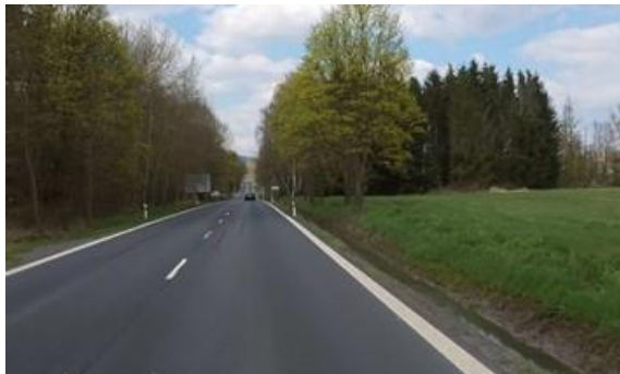
Obrázek 42 – Ukázka neadekvátního odvodnění silničního příkopu na silnici I/21 ve směru staničení km 56,531. (ID 3971) [4]
