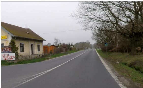
Obrázek 14 – Původní příkop mezi silnicí a pevnými překážkami na silnici I/21 ve směru staničení km 56,102. (ID 2360) [4]
