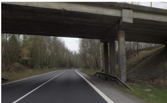
Obrázek 94 – Ilustrativní ukázka krátkého svodidla před – nosným pilířem v okolí komunikace na silnici I/64 ve směru staničení km 5,187. (ID 209) [4] (PŘED ELIMINACÍ)
