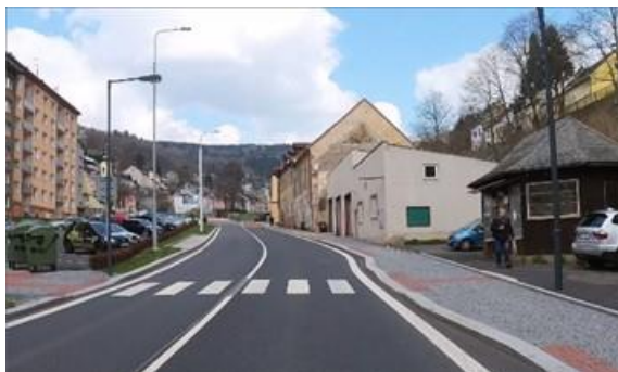
Obrázek 36 – Ukázka absence SDZ u přechodu pro chodce na silnici I/25 ve směru staničení km 6,195. (ID 3820) [4]
