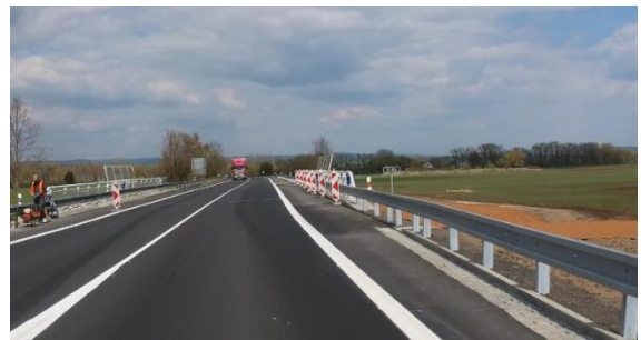
Obrázek 79 – Ilustrativní ukázka neadekvátního provedení svodidla na silnici I/21 ve směru staničení km 51,681. (ID 2279) [4] (PO ELIMINACI)
