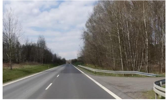
Obrázek 91 – Ilustrativní ukázka liniové vegetace v těsné blízkosti komunikace na silnici I/64 ve směru staničení km 13,156. (ID 287) [4] (PO ELIMINACI)
