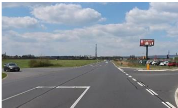
Obrázek 26 – Ukázka absence a opotřebovaného VDZ v křižovatce na silnici I/21 ve směru staničení km 53,949. (ID 2325) [4]
