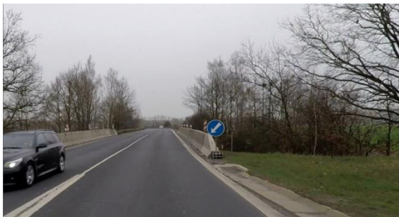
Obrázek 78 – Ilustrativní ukázka krátkého svodidla před – mostem na silnici I/21 ve směru staničení km 51,681. (ID 2279) [4] (PŘED ELIMINACÍ)
