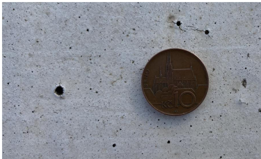
Obrázek 32 - Charakteristický snímek VDZ bez balotínového posypu 4F
