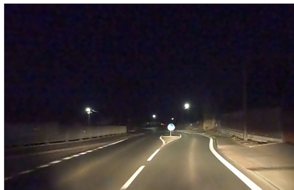
Obrázek 39 – Absence přisvětlení místa pro přecházení (PLZ | ID 7650). [5]
