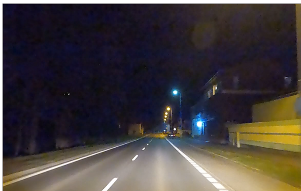
Obrázek 34 – Neadekvátní osvětlení dopravního prostoru (PLZ | ID 8565). [5]
