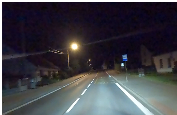
Obrázek 16 – Neadekvátní světelně-technické vlastnosti VDZ (PLZ | ID 8564). [5]
