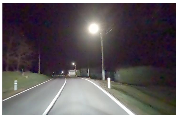
Obrázek 29 – Neadekvátní osvětlení dopravního prostoru (PLZ | ID 8165). [5]
