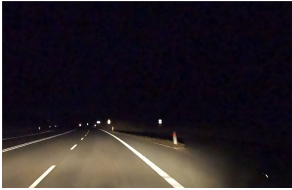
Obrázek 63 – Neadekvátní postřehnutelnost dopravního ostrůvku (PLZ | ID 5496). [5]
