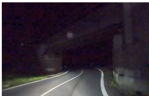
Obrázek 80 – Neadekvátní postřehnutelnost pevné překážky (PLZ | ID 6967). [5]
