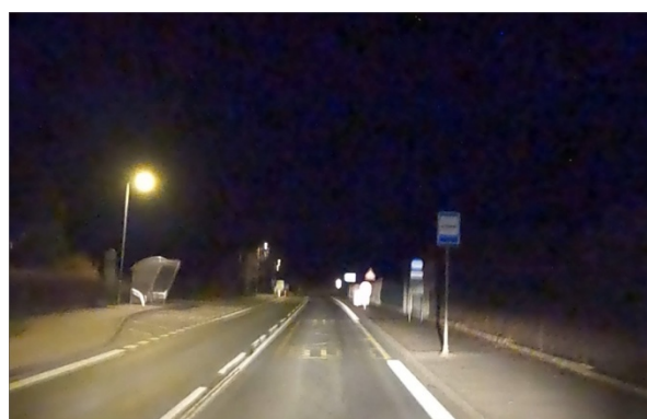
Obrázek 59 – Neadekvátní postřehnutelnost autobusové zastávky (PLZ | ID 7973). [5]
