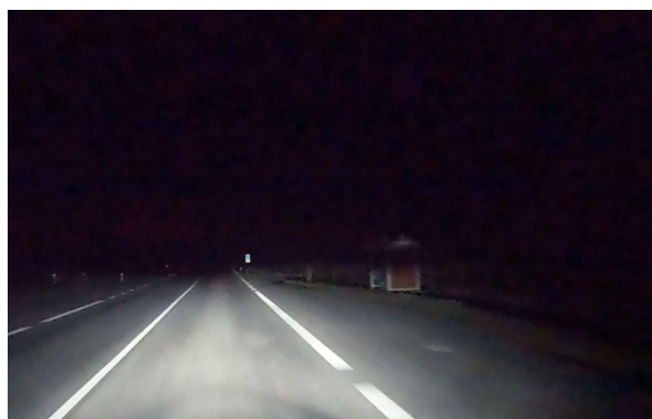
Obrázek 56 – Neadekvátní postřehnutelnost autobusové zastávky (JCK | ID 13197). [5]
