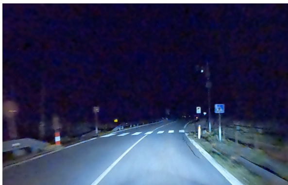
Obrázek 53 – Neadekvátní postřehnutelnost přechodu pro chodce (JCK | ID 1593). [5]
