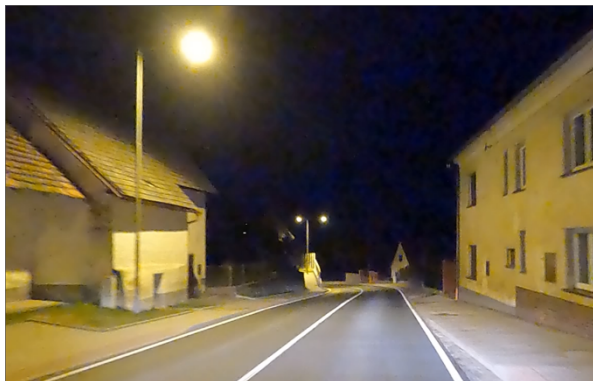
Obrázek 23 – Absence osvětlení dopravního prostoru (PLZ | ID 8582). [5]
