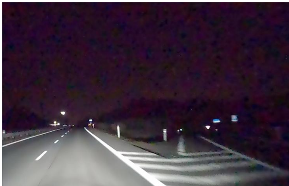
Obrázek 65 – Neadekvátní postřehnutelnost dopravního ostrůvku (PLZ | ID 5775). [5]
