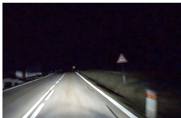
Obrázek 8 – Neadekvátní světelně-technické vlastnosti SDZ (JCK | ID 41252). [5]
