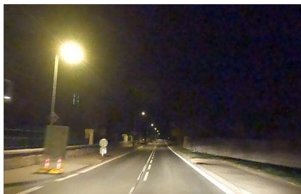
Obrázek 36 – Absence přisvětlení místa pro přecházení (PLZ | ID 6050). [5]
