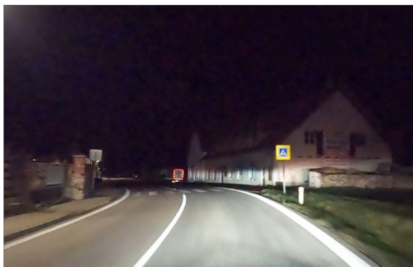
Obrázek 38 – Absence přisvětlení přechodu pro chodce (JCK | ID 1114). [5]
