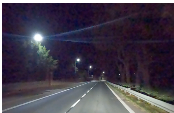
Obrázek 28 – Neadekvátní osvětlení dopravního prostoru (JCK | ID 40970). [5]
