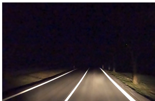
Obrázek 94 – Neadekvátní srozumitelnost vedení trasy (PLZ | ID 8590). [5]
