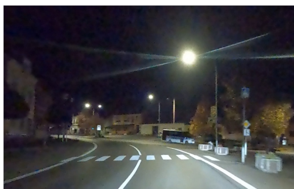
Obrázek 41 – Neadekvátní přisvětlení přechodu pro chodce (JCK | ID 5166). [5]
