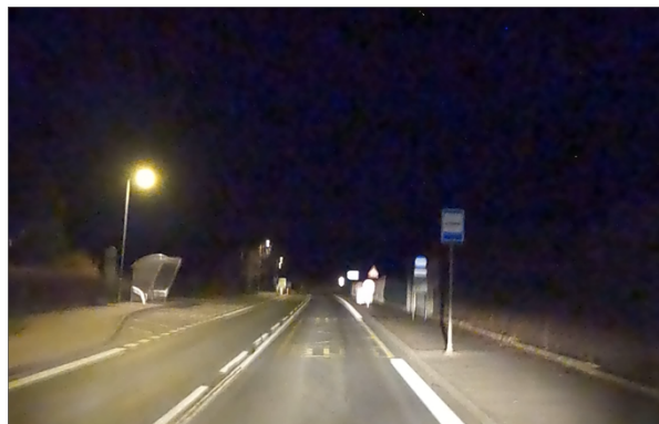
Obrázek 15 – Neadekvátní světelně-technické vlastnosti VDZ (PLZ | ID 7973). [5]
