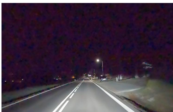
Obrázek 32 – Neadekvátní osvětlení dopravního prostoru (PLZ | ID 8078). [5]
