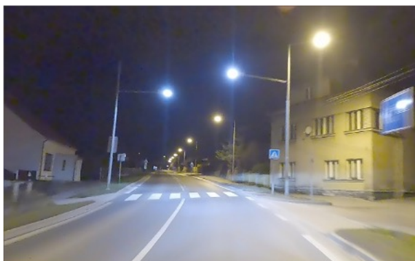
Obrázek 40 – Adekvátní přisvětlení přechodu pro chodce. [5]
