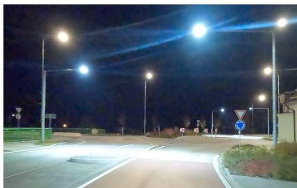
Obrázek 45 – Adekvátní přisvětlení přechodu pro chodce. [5]
