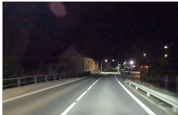
Obrázek 24 – Absence osvětlení dopravního prostoru (JCK | ID 40945). [5]
