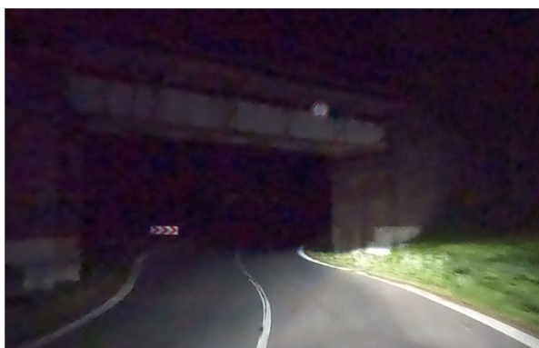
Obrázek 79 – Neadekvátní postřehnutelnost pevné překážky (PLZ | ID 6973). [5]
