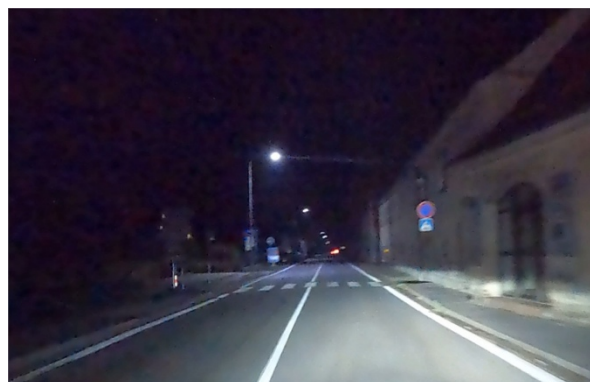
Obrázek 37 – Absence přisvětlení přechodu pro chodce (JCK | ID 7629). [5]
