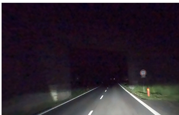
Obrázek 81 – Neadekvátní postřehnutelnost pevné překážky (PLZ | ID 7741). [5]
