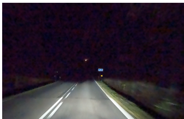
Obrázek 13 – Neadekvátní světelně-technické vlastnosti VDZ (JCK | ID 41075). [5]
