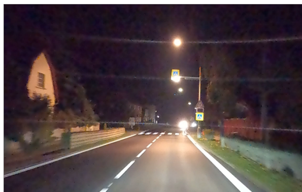
Obrázek 43 – Neadekvátní přisvětlení přechodu pro chodce (JCK | ID 262). [5]
