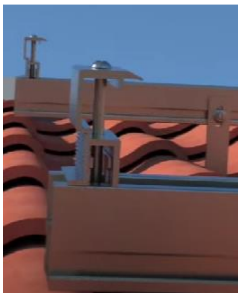
Obrázek 25 - uchycení panelové svorky
