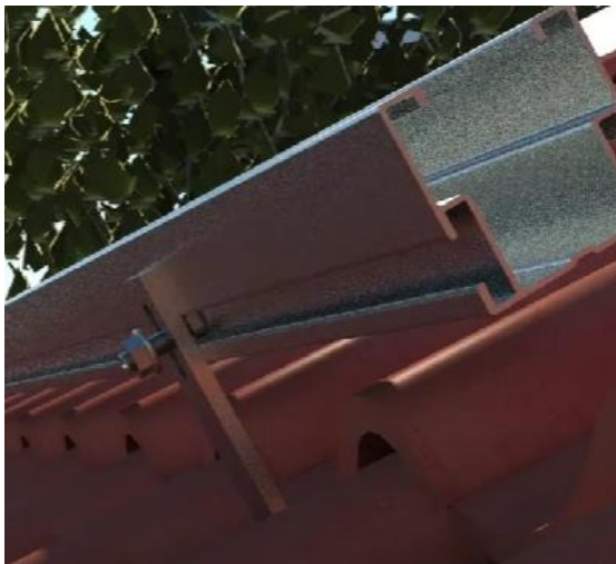
Obrázek 24 - příklad uchycení vodících profilů
