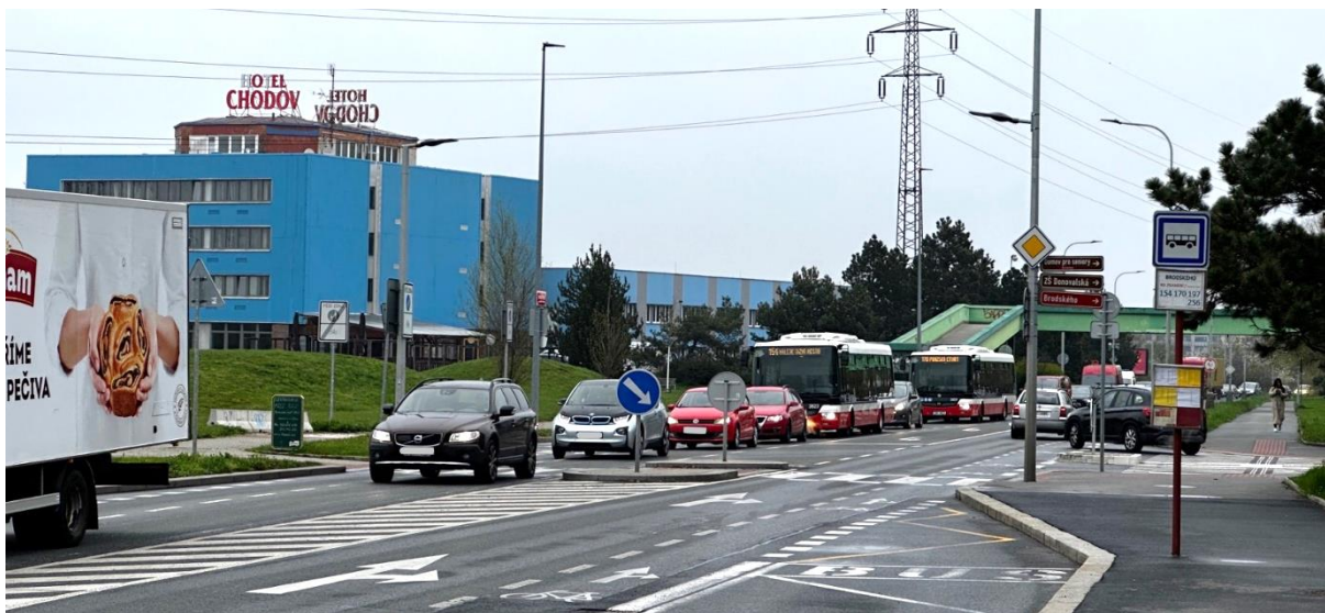
Obrázek 12 Příklad přechodu rozděleného ochranným ostrůvkem včetně vzdutí vozidel před dalším přechodem pro chodce řízeným SSZ (není v záběru). Praha, Mírového hnutí. Zdroj: archiv autora
