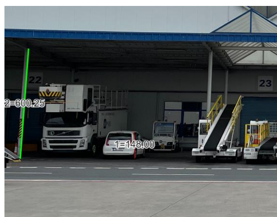
Obrázek 5.12 Výška nástřešku terminálu Menzies
