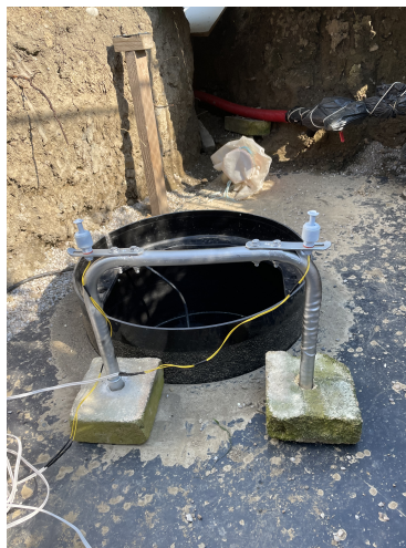
Obrázek 7: Koncové spínače monitorující minimální hladinu v zalévací nádrži
