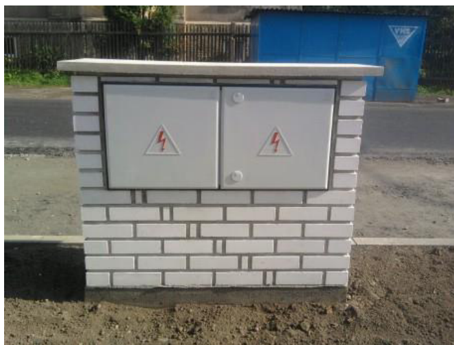
Obr. 6: Rozpojovací skříň typu SR502 [F]
