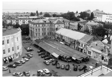
Výhled na hotel před demolicí
