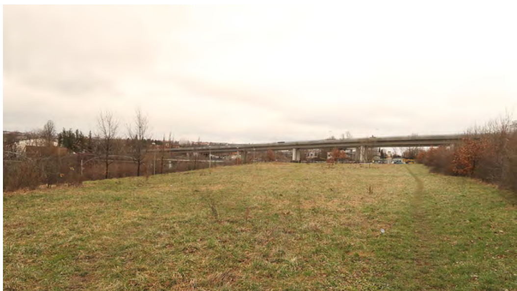
pohled na estakádu
