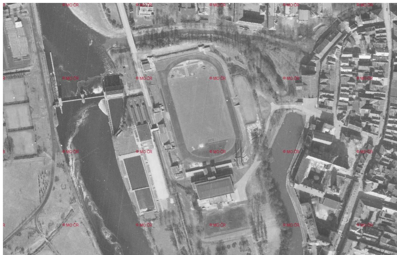
(Obr. 38 – Sokolský ostrov - ortofoto, 1961. Zdroj: Ministerstvo obrany České republiky. Dostupné z: geoportal.cuzk.cz )
