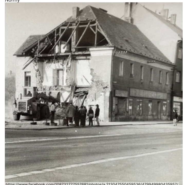
Palackého náměstí (1990), bourání domů na západní straně pro novou budovu Normy
