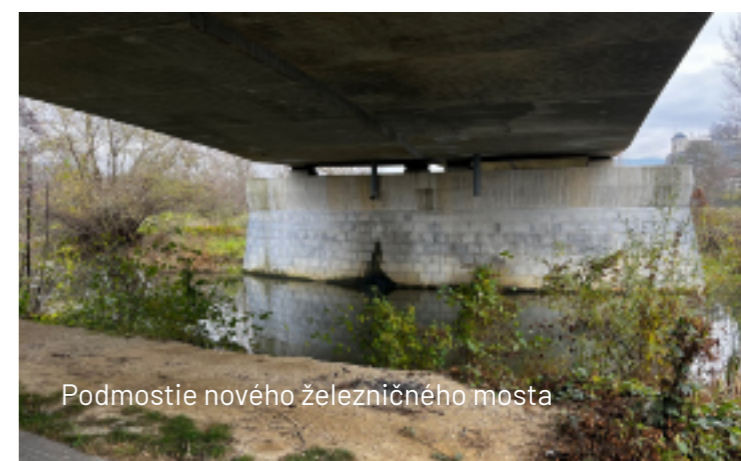
Nový železničný most zamedzil peristupnosť po hrádzi
