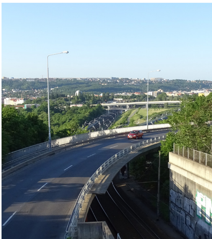
24 pohled z Ohrady 2009 po dokončení Nového vedení v současné podobě
