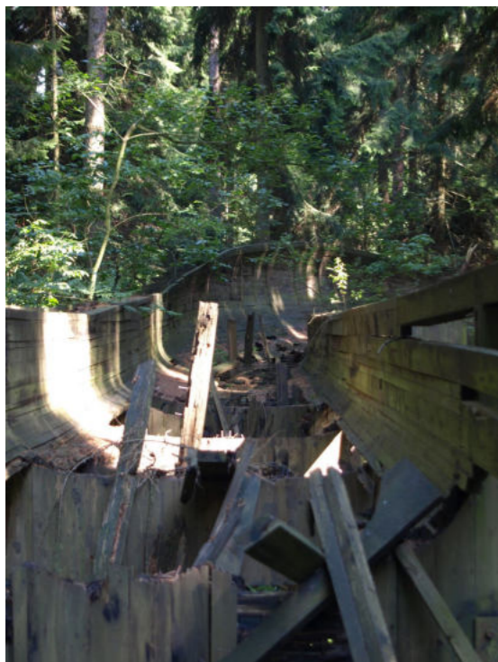
Obr. č. 101-102: Pohled z nultých let 21. století na zbytky chátrajícího dřevěného žlabu sáňkařské dráhy, zbudovaného v 70./80. letech.
