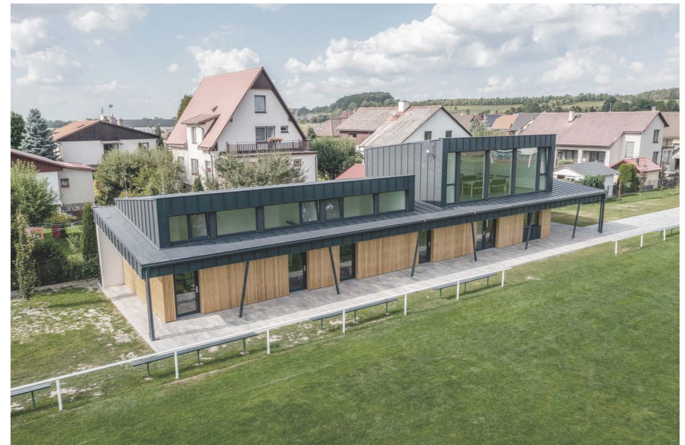
plášť střechy z falcovaného plechu, fasáda hlavního podlaží obložena dřevem
