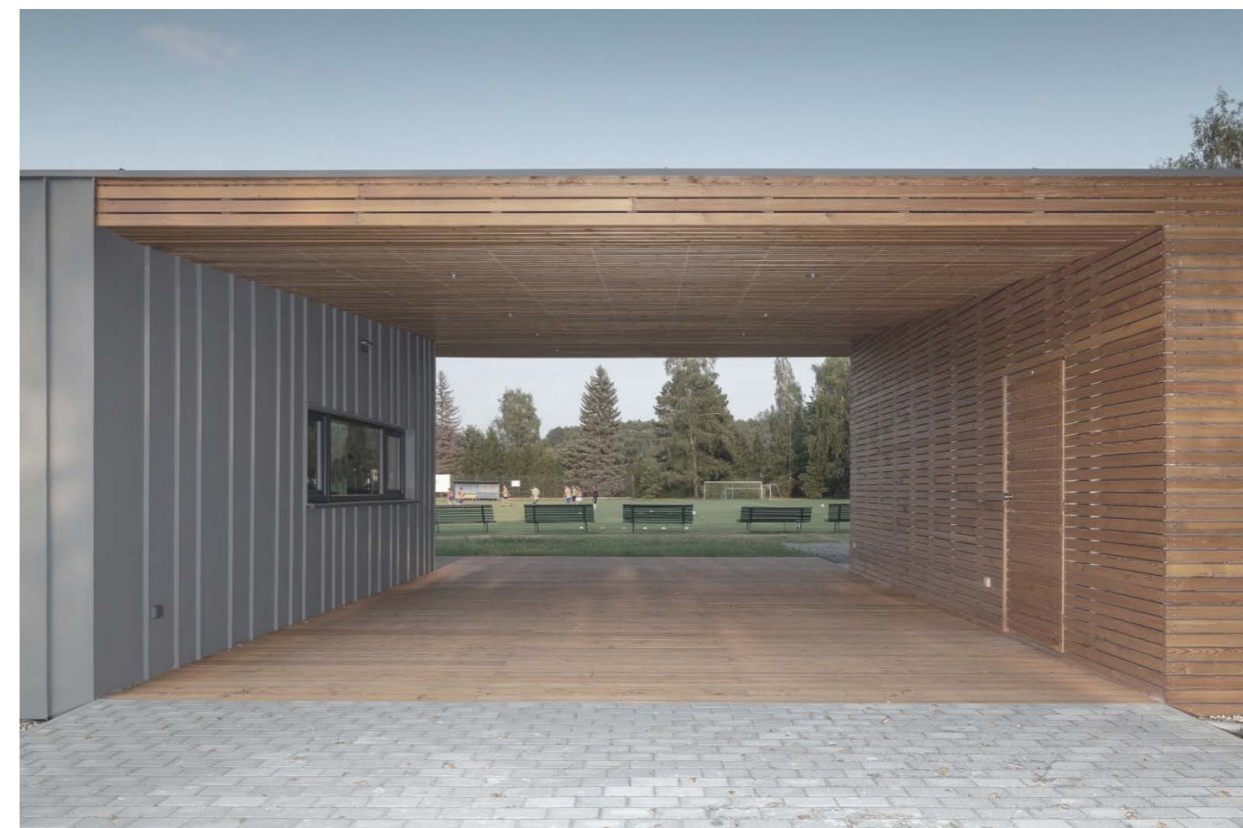
průchod s okýnkem pro vybírání vstupného
