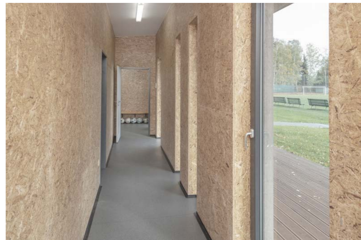
chodba se vstupy do jednotlivých šatek a možností výlezu na dřevěnou terasu
