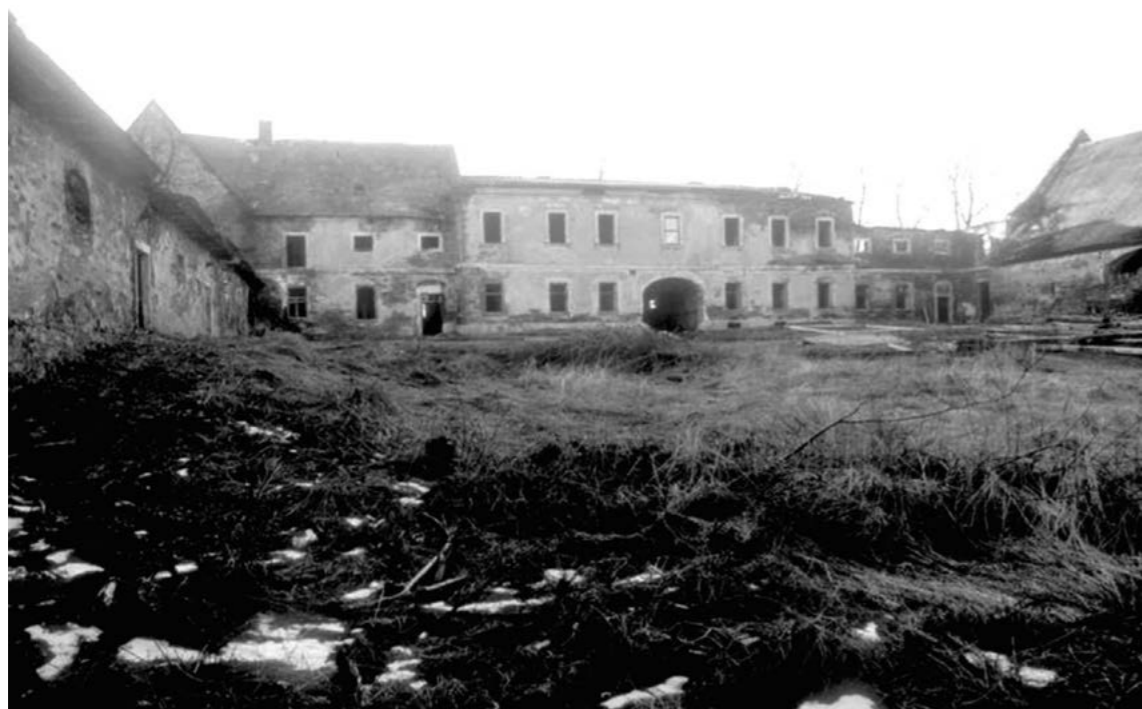
34 pohled do dvora severozápadním směrem (před rokem 2000)
