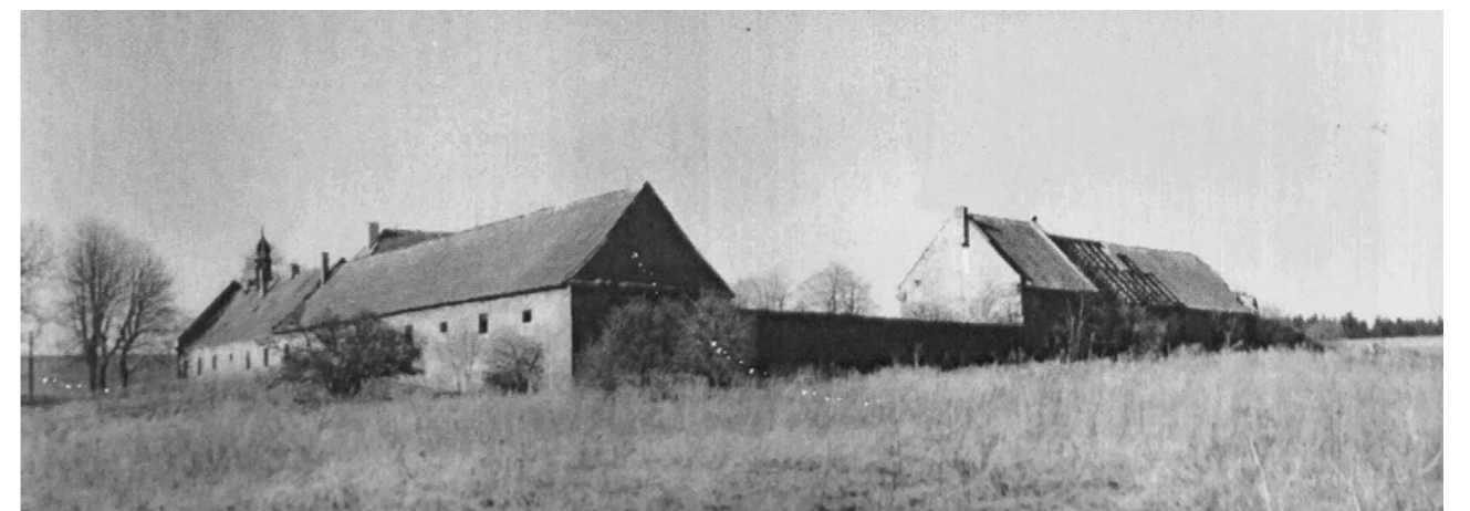
celkový pohled od jihovýchodu
