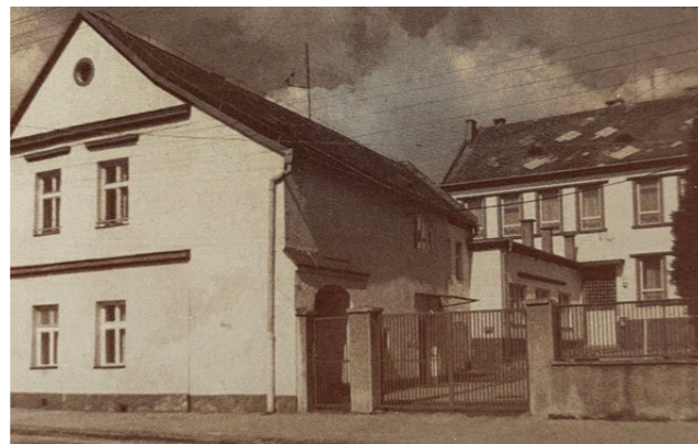
obr.24 | evanjelická škola na Alstrovej ulici
