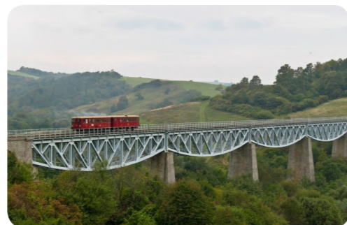
8 pohľad na Hrabovský viadukt
