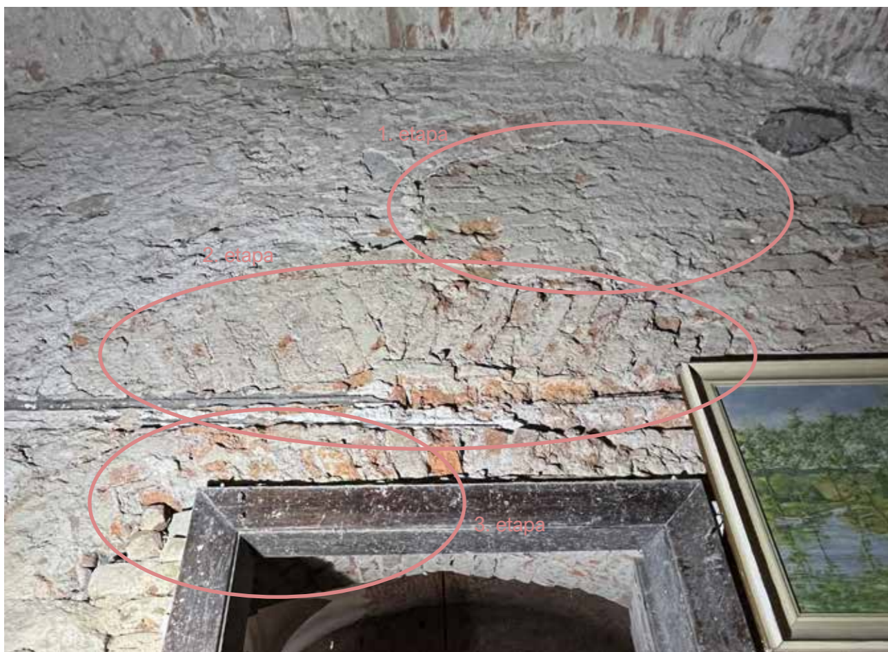
obr.64: Místnost 1.04, viditelné tři etapy otvoru dveří
