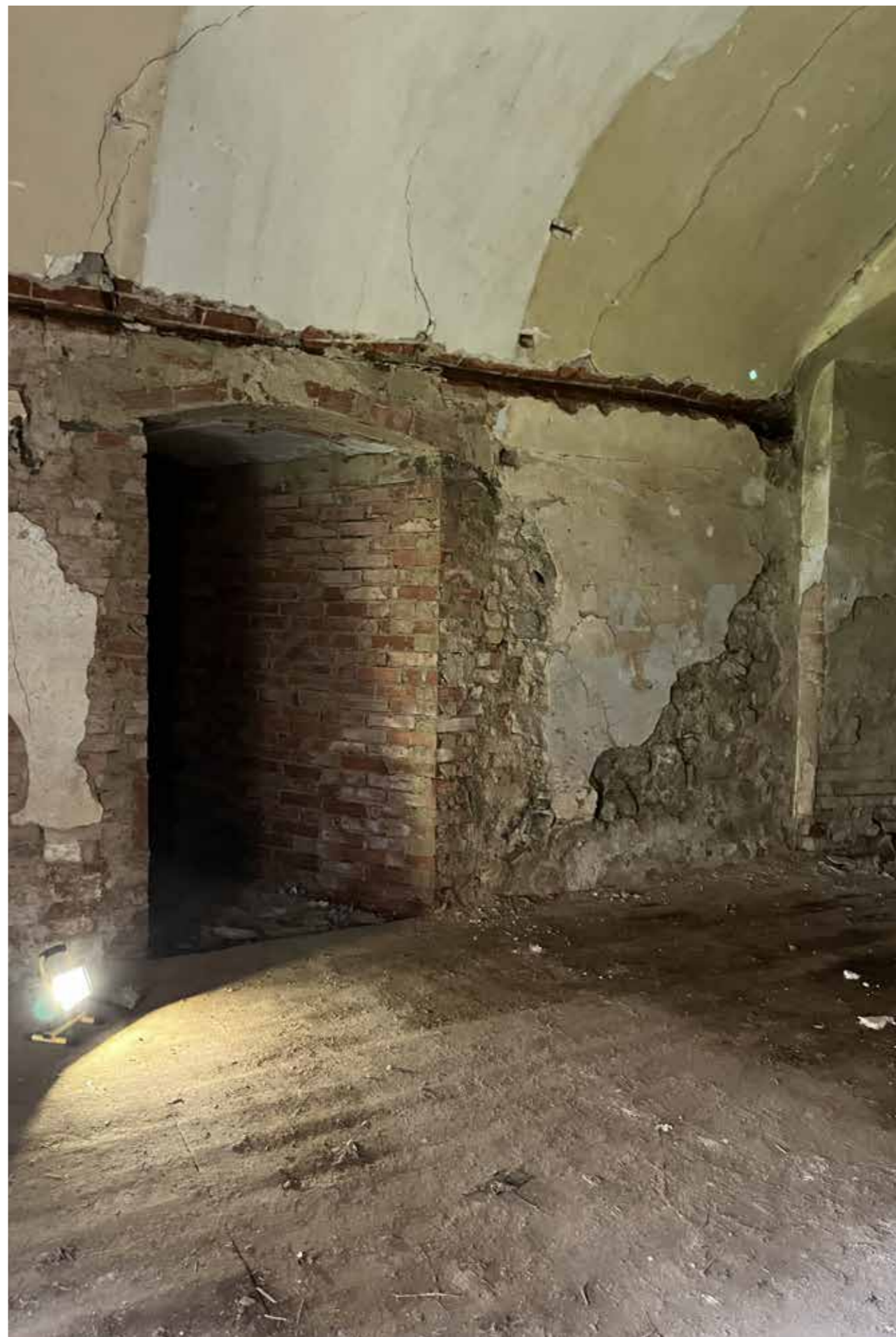
obr.68: Místnost 1.08, vstup do místnosti 1.09
