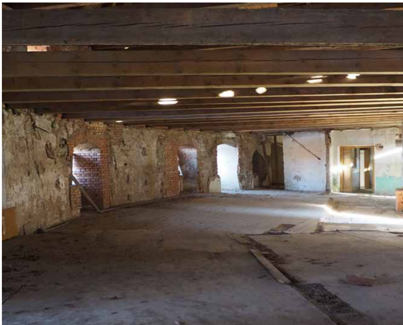
obr.48: správcovské křídlo, pohled na stropní trámy
