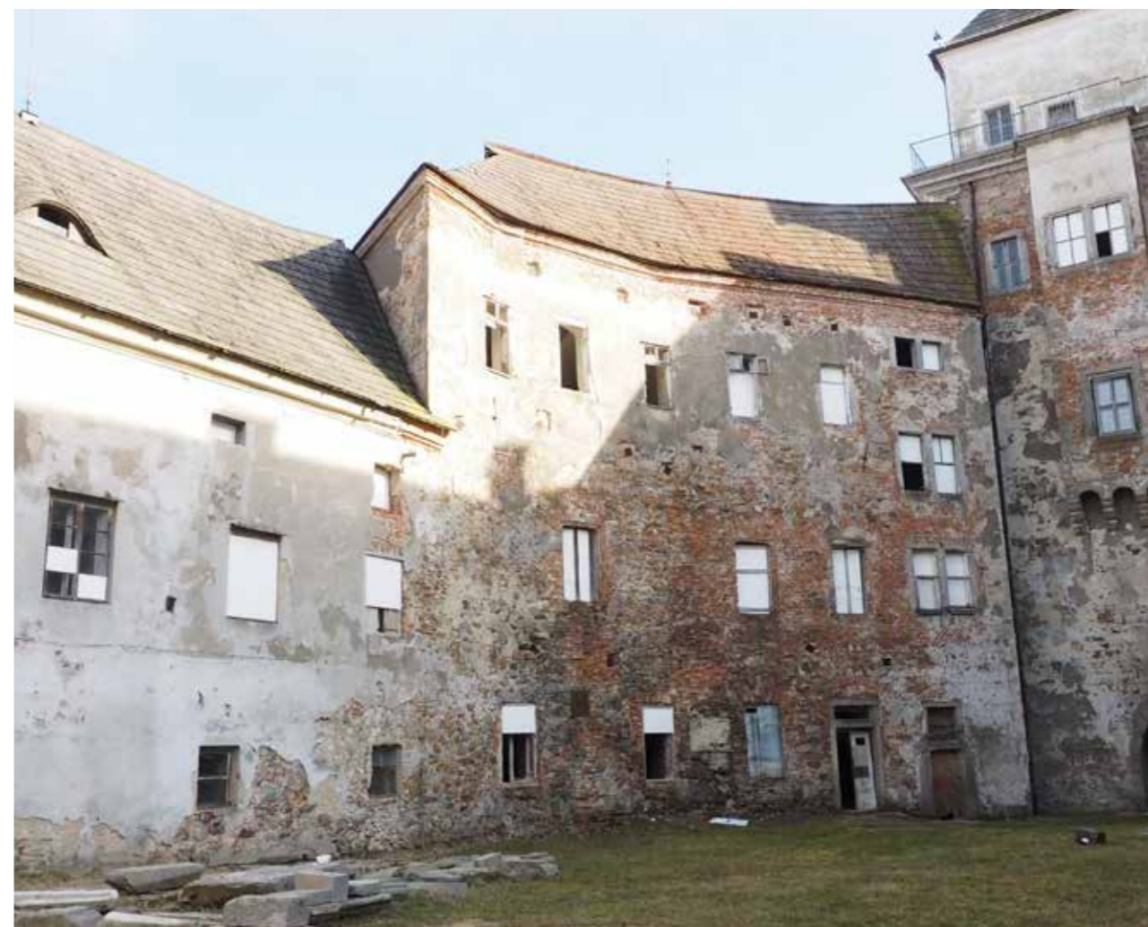
obr.31: Pohled na malý palác, správčovské křídlo a věž
