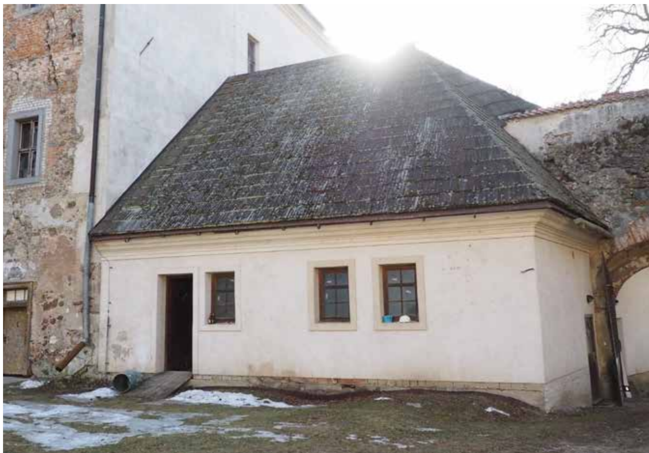
obr.33: Pohled na správčovský dům a vedlejší bránu
