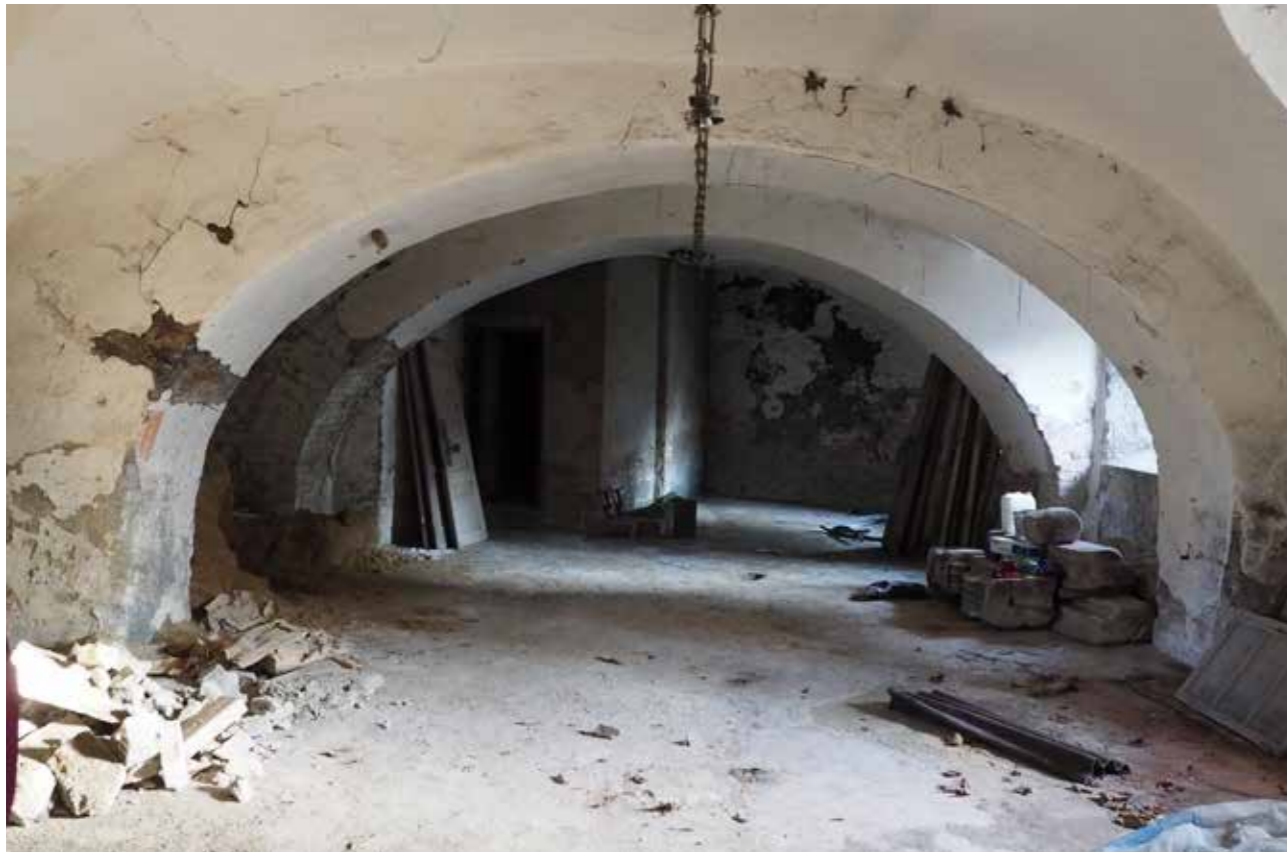
obr.44: Místnost 1.12, pohled do místnosti
