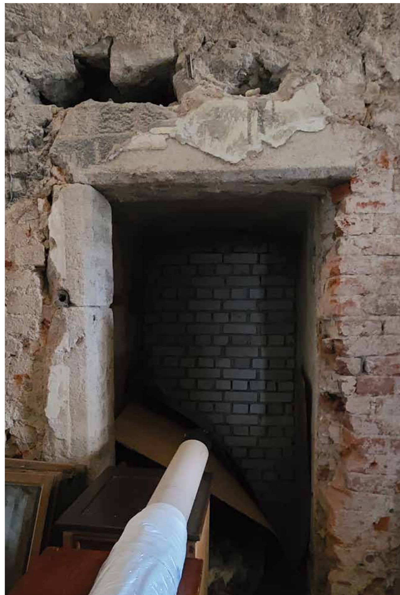
obr.66: Místnost 1.05, kamenné ostění záchoda
