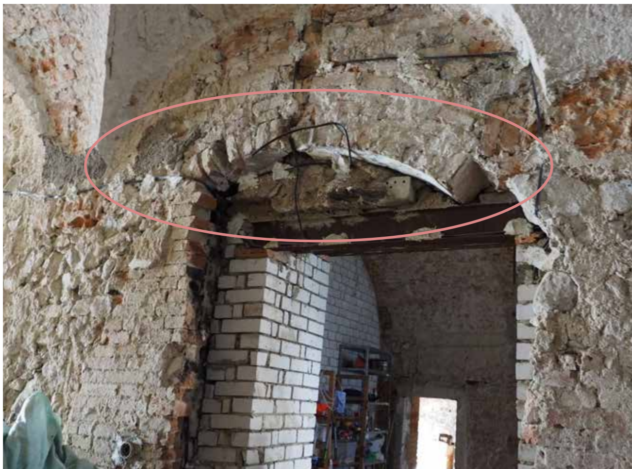
obr.60: Dveře mezi místnostmi 1.02 a 1.03, viditelná klenba původního otvoru dveří
