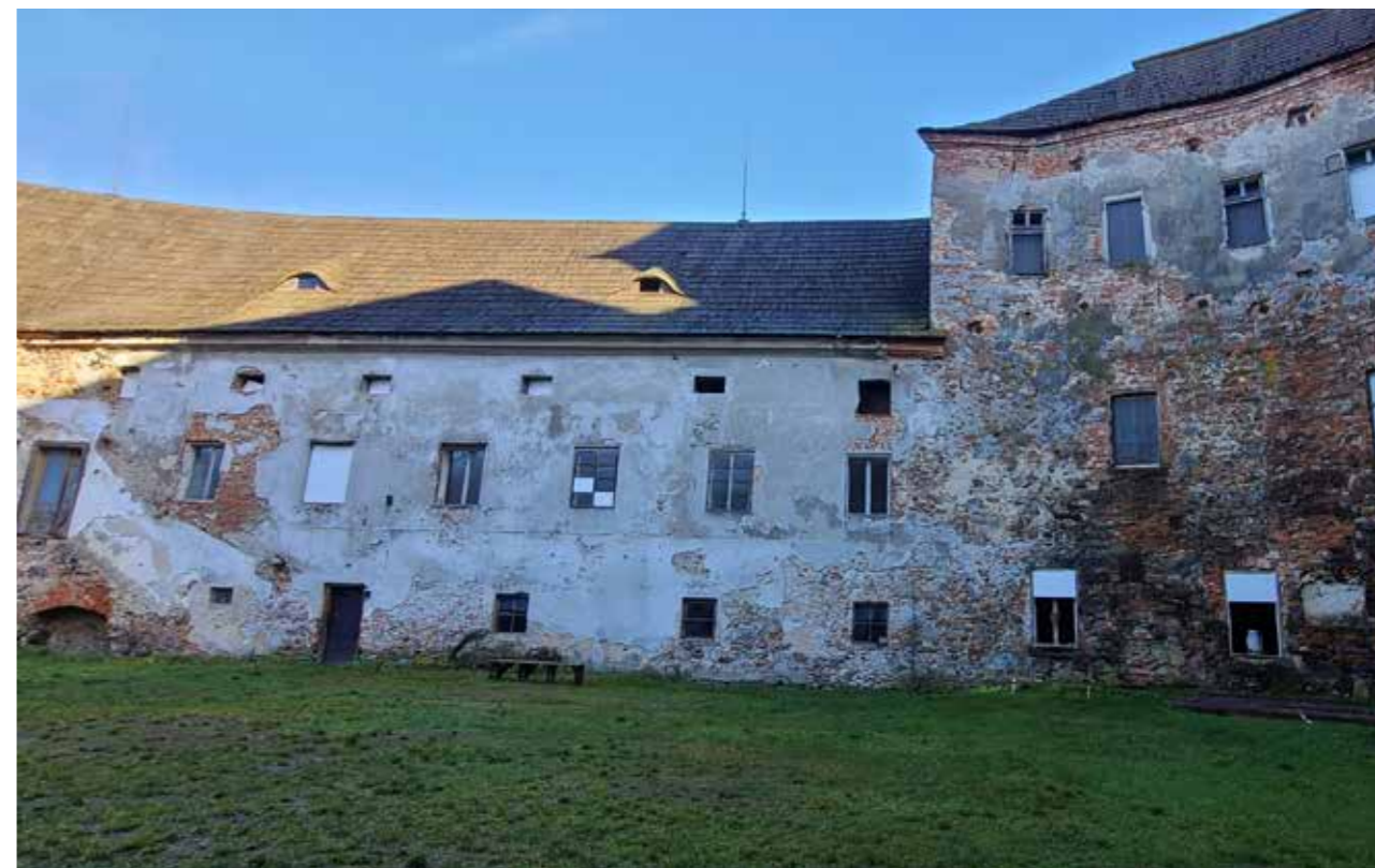
obr.30: Pohled na malý palác a správčovské křídlo
