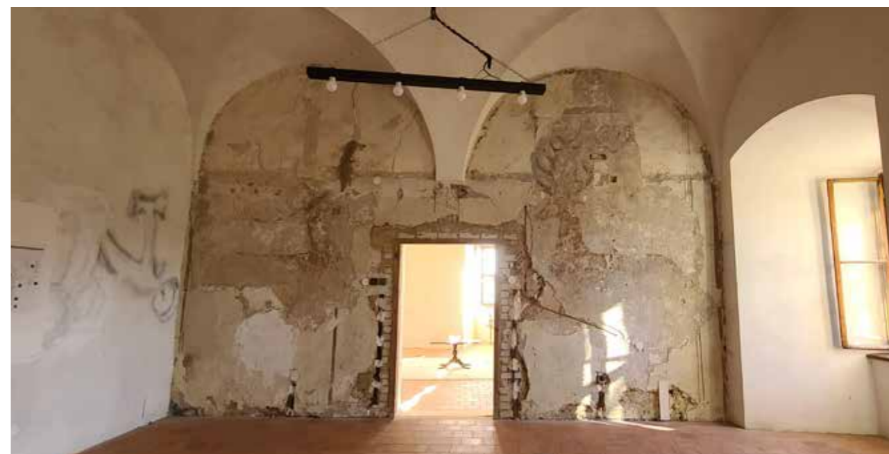
obr.70: Místnost 2.05, částečně zachovalá freska jelenů
