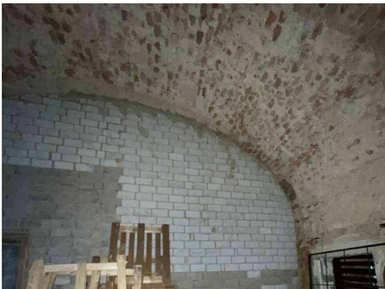
obr.41: Místnost 1.04, pohled na novodobou přičku
