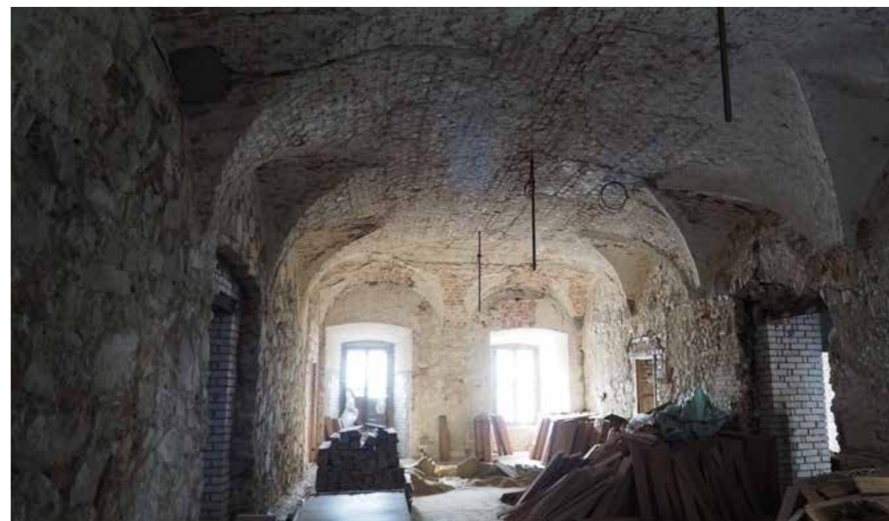
obr.39: Místnost 1.02, pohled ode dveří
