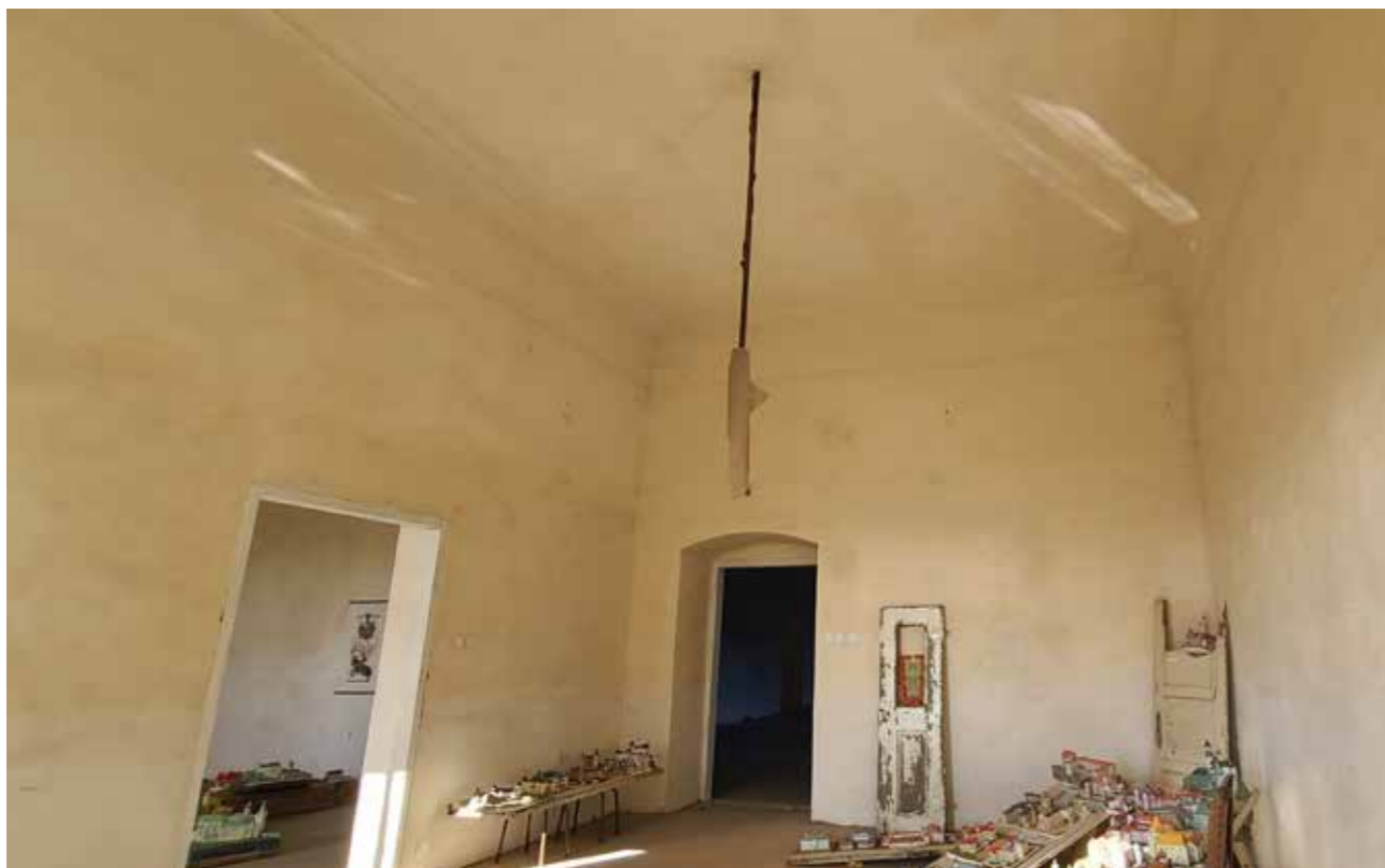
obr.49: Místnost 3.02, pohled do místnosti
