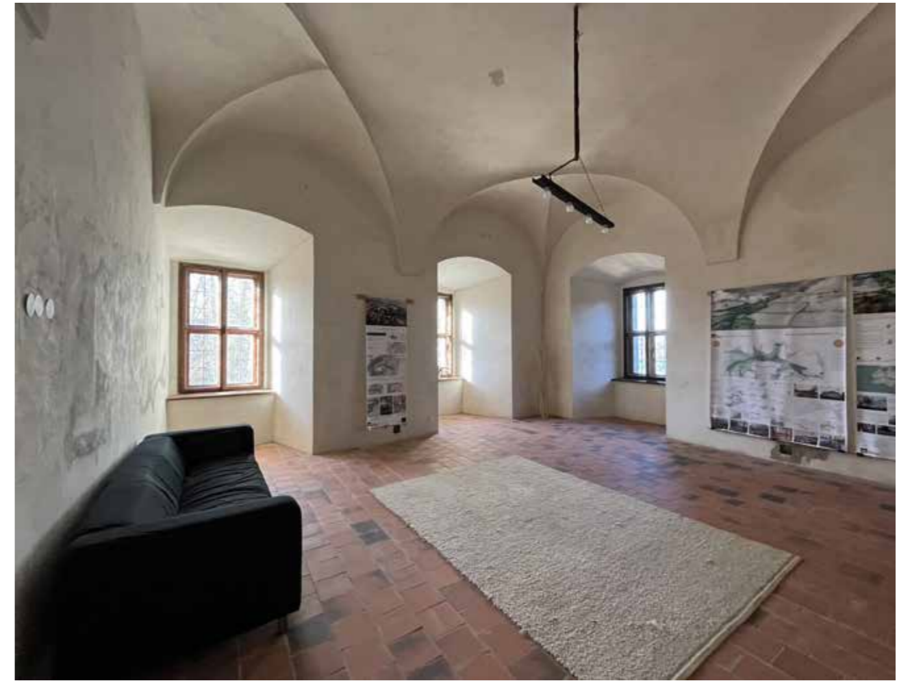
obr.46: Místnost 2.02, pohled do místnosti
