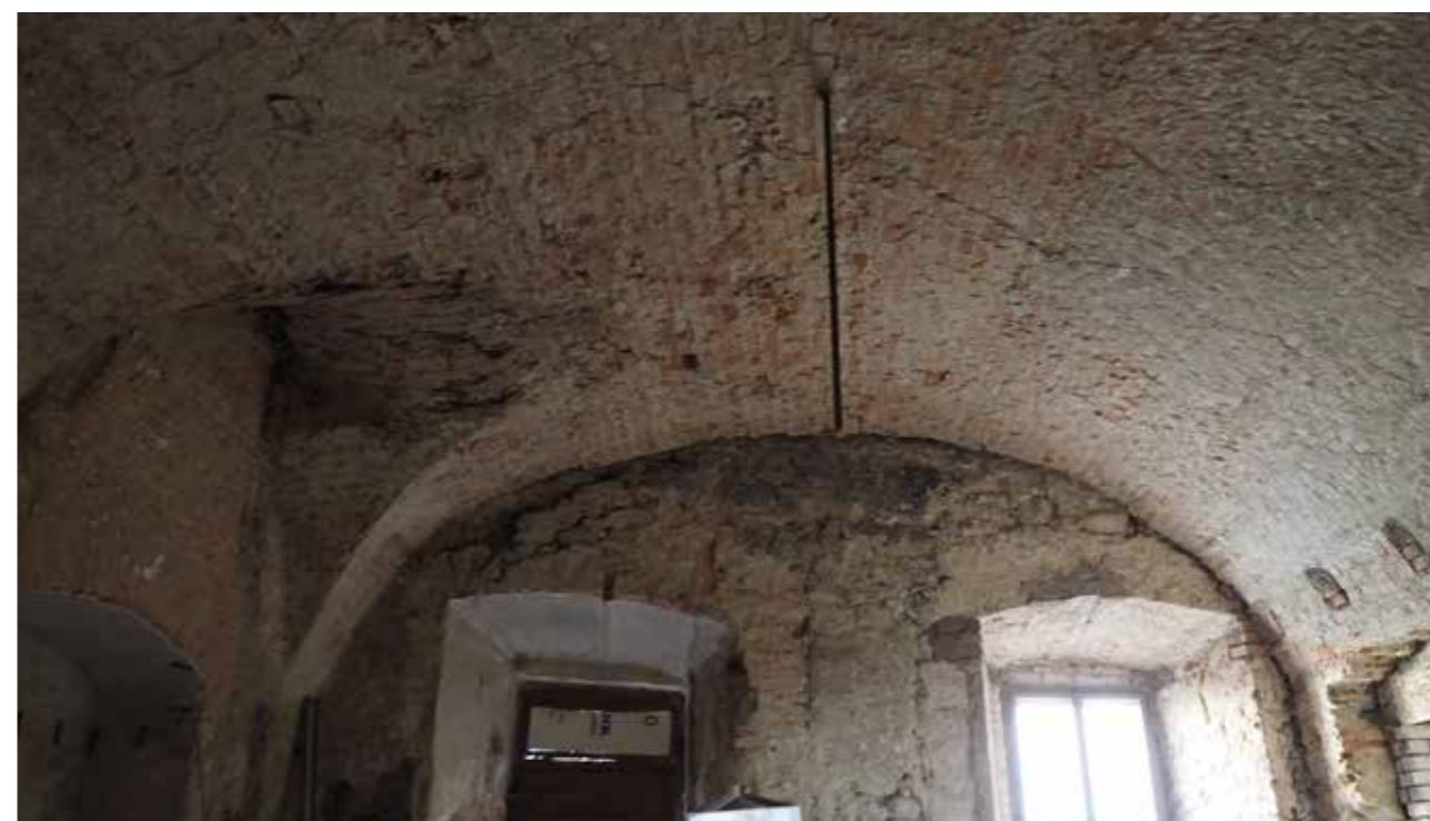
obr.43: Místnost 1.04, pohled na dveře z nádvoří
