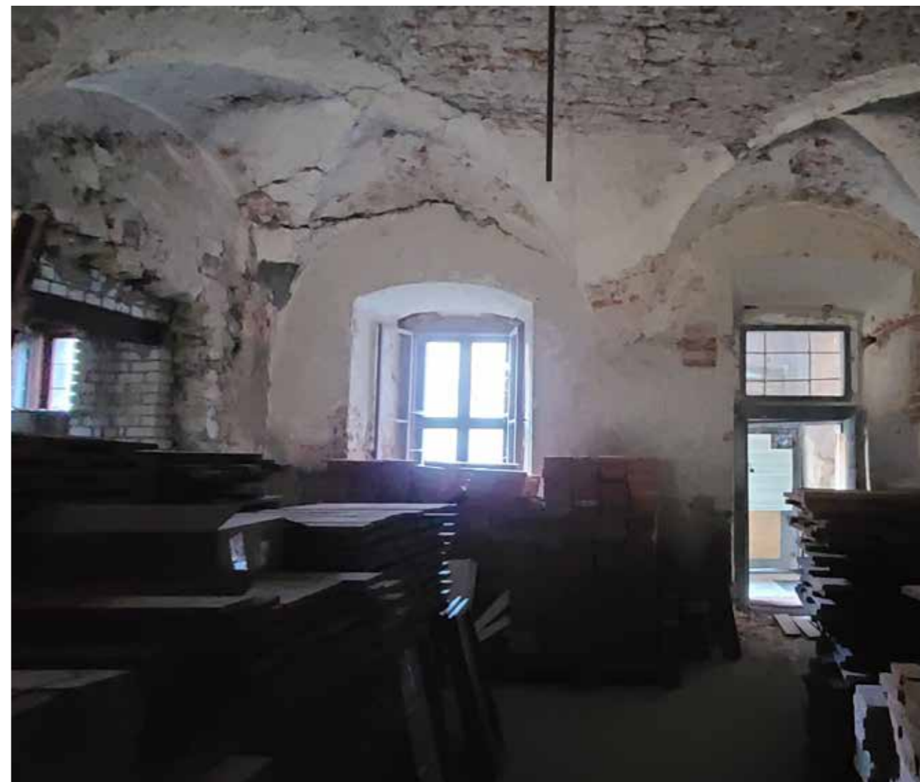
obr.38: Místnost 1.02, pohled na vstup
