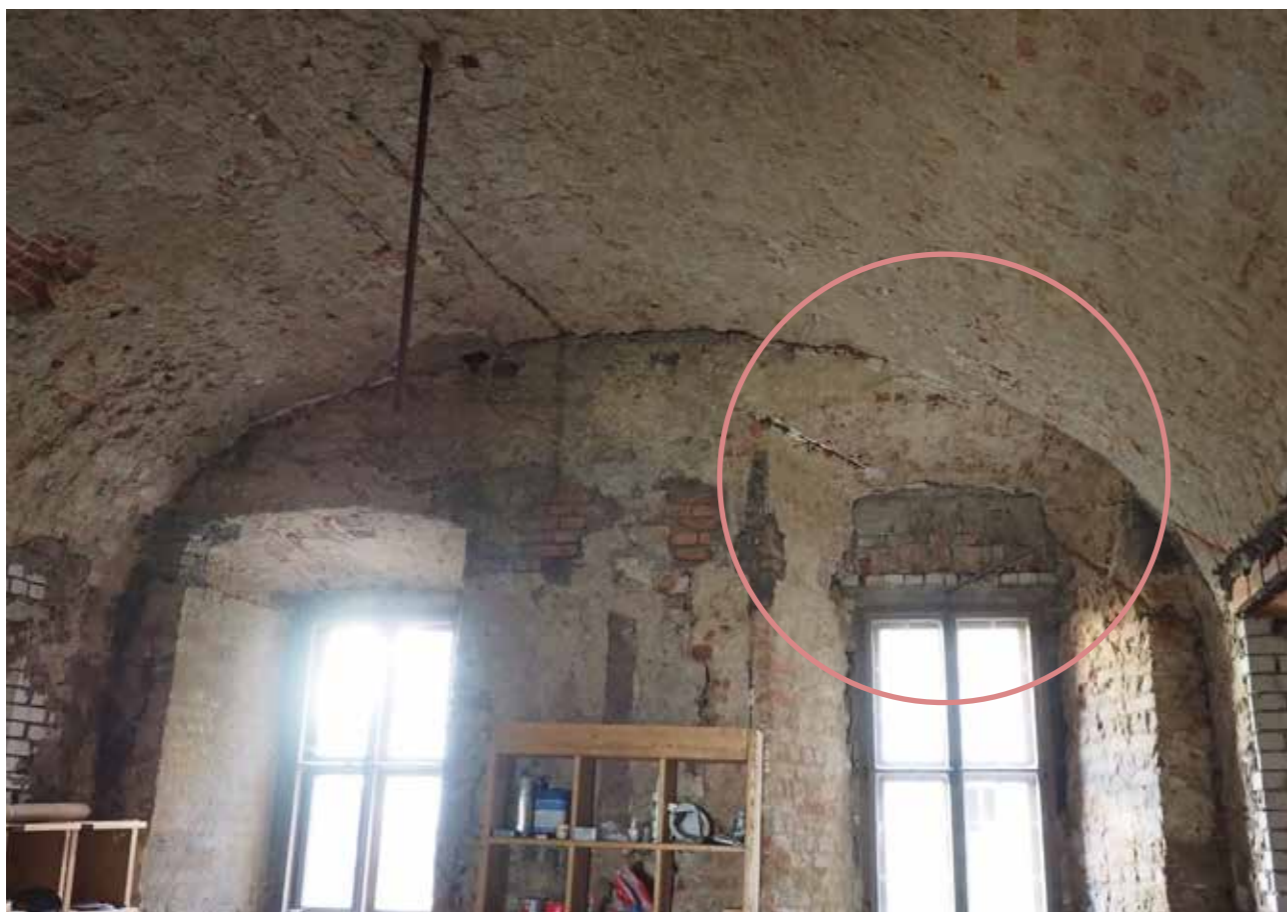
obr.61: Místnost 1.03, stěna do nádvoří, pravý záklenek po původních dveřích ze světlíkem
