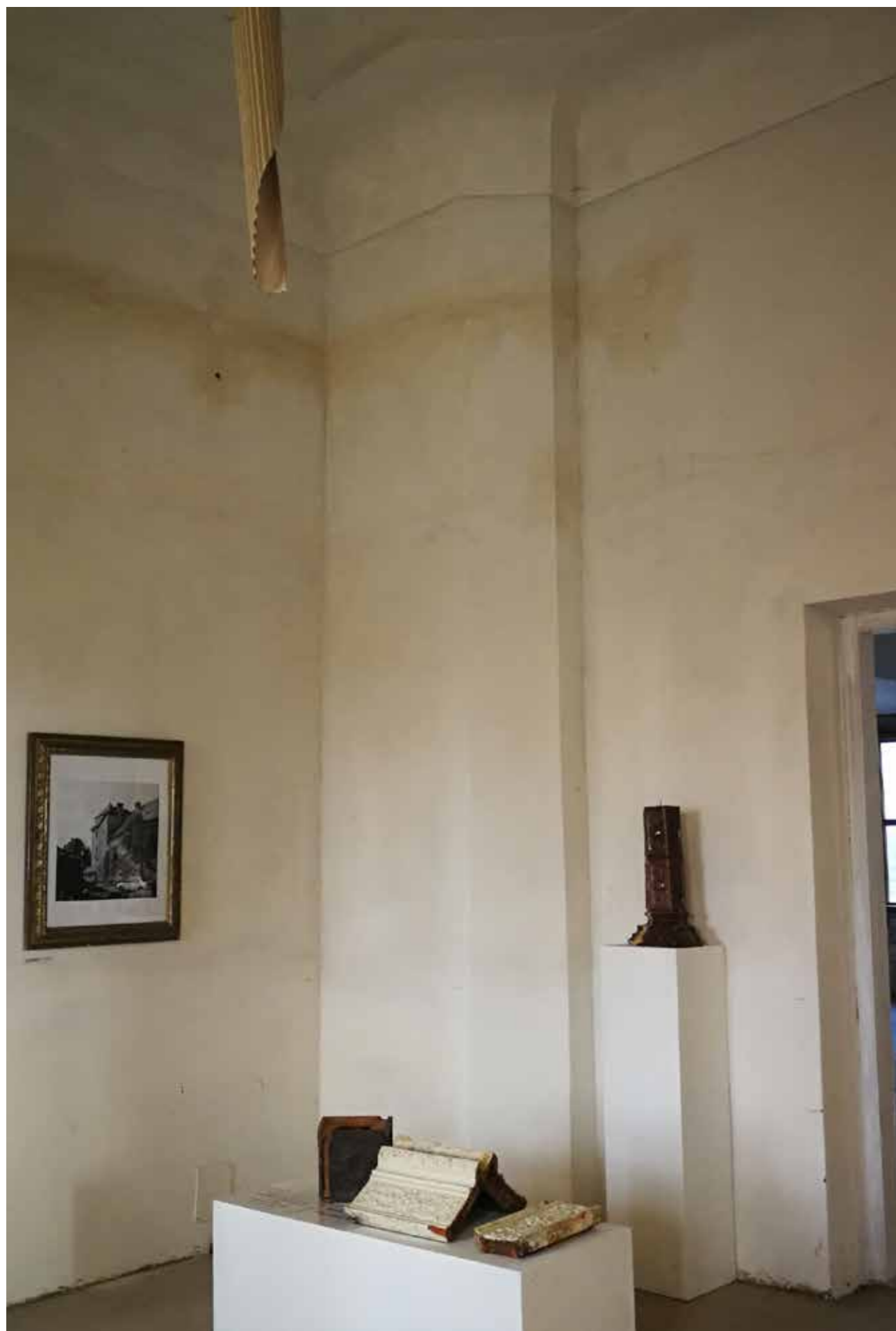
obr.72: Místnost 3.03, bývalé umístění krbu, později nahrazeného kamny
