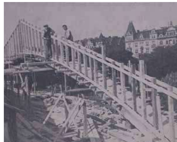
▲ Vynášení konstrukce střechy v létě roku 1938
