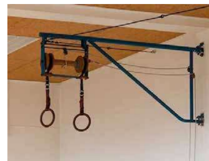
▲ Konzole pro uchycení kruhů s ústrojím, vpravo jsou viditelné otočné čepy
