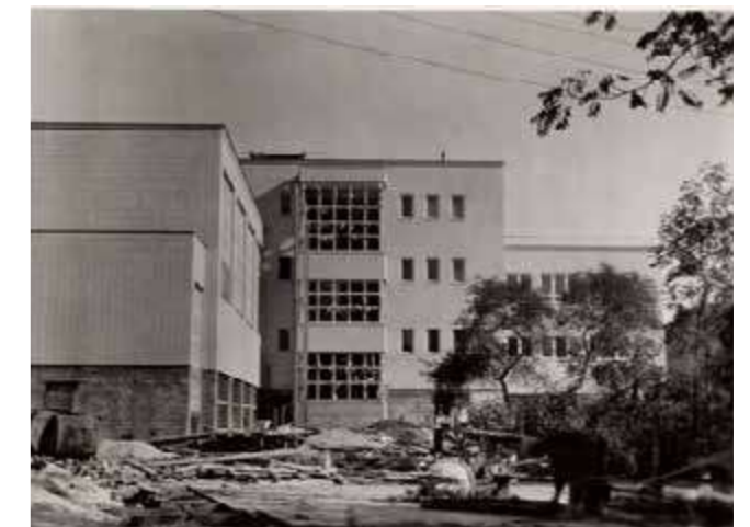
▼ Dokončení fasád, květen 1940
