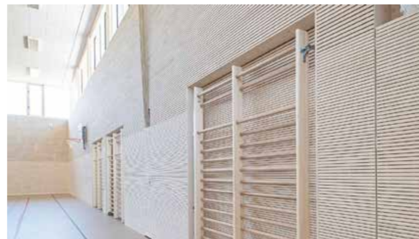
◀ Příklad obložení sportovní haly lamelovými akustickými panely. Ty vyjma akustiky v sobě mohou integrovat různé nářadí.
