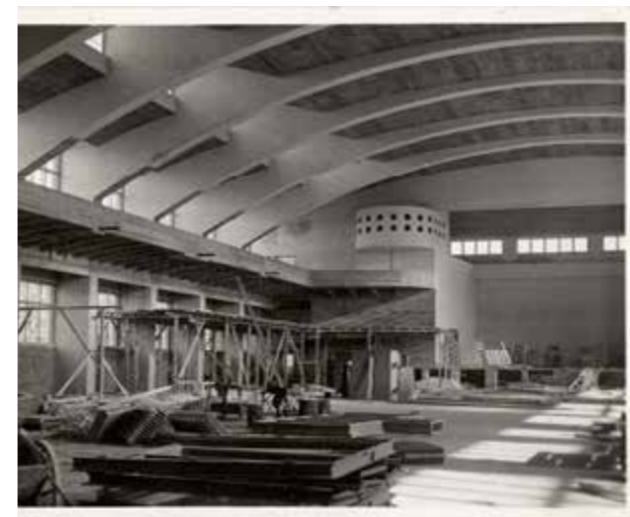
▲ Betonáž hlavního sálu, stav k roku 1940
