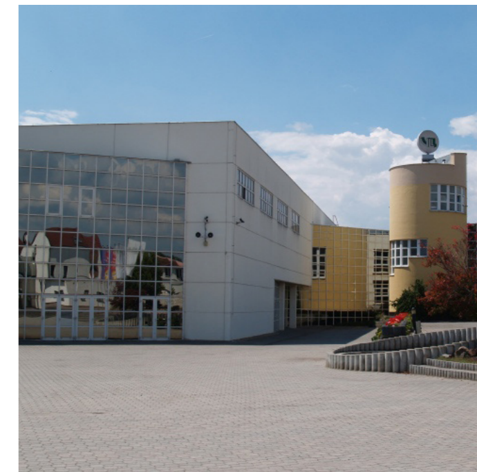
Výstaviště Lysá nad Labem obr.č. 26
